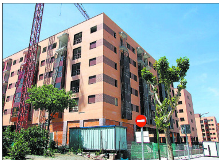
Pisos en construcción en el polígono de Las Mercedes.
