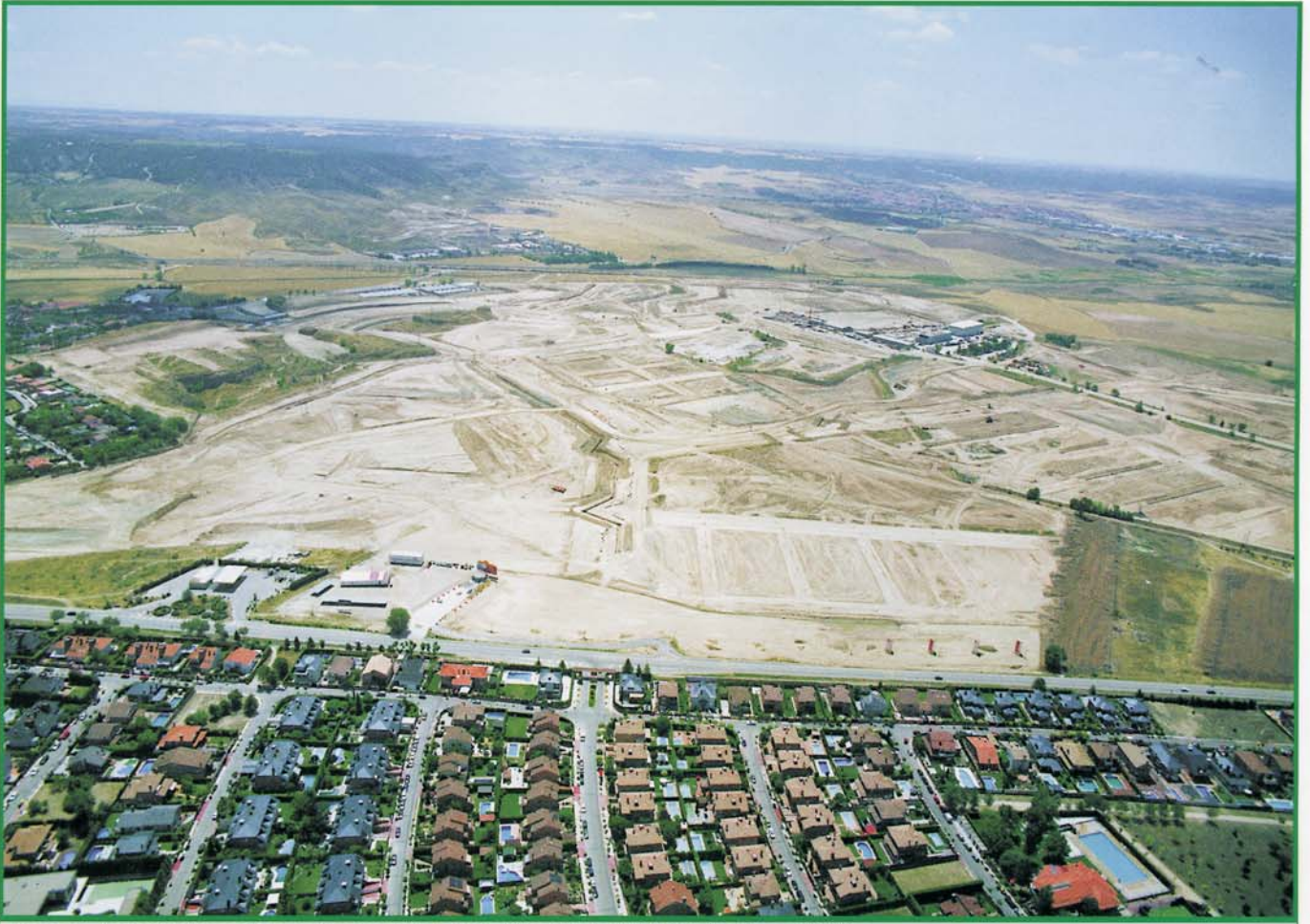
Imagen general aérea de los terrenos donde se edificarán las 3.500 viviendas en El Viso
