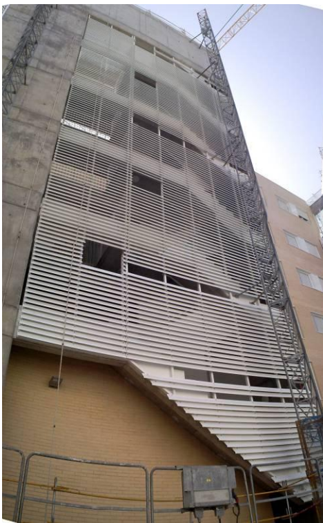
DETALLE DE CIERRE DE CERRAJERÍA Y LAMAS EN ESCALERAS (PORTAL 1)
