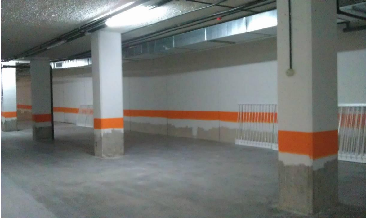
PINTURA EN PARAMENTOS VERTICALES DE SÓTANO -1
