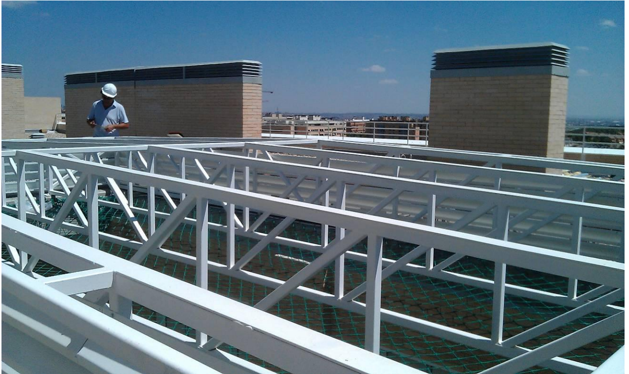
DETALLE DE CELOSÍAS PARA LUCERNARIO EN CUBIERTA
