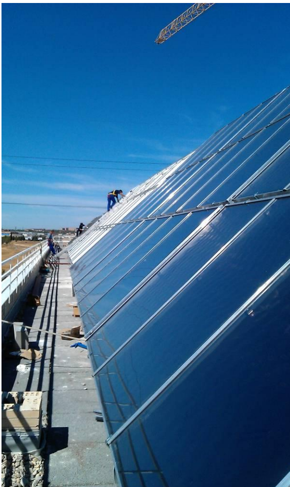
INSTALACIÓN DE PANELES; TRABAJOS EN CUARTO DE CALDERAS
