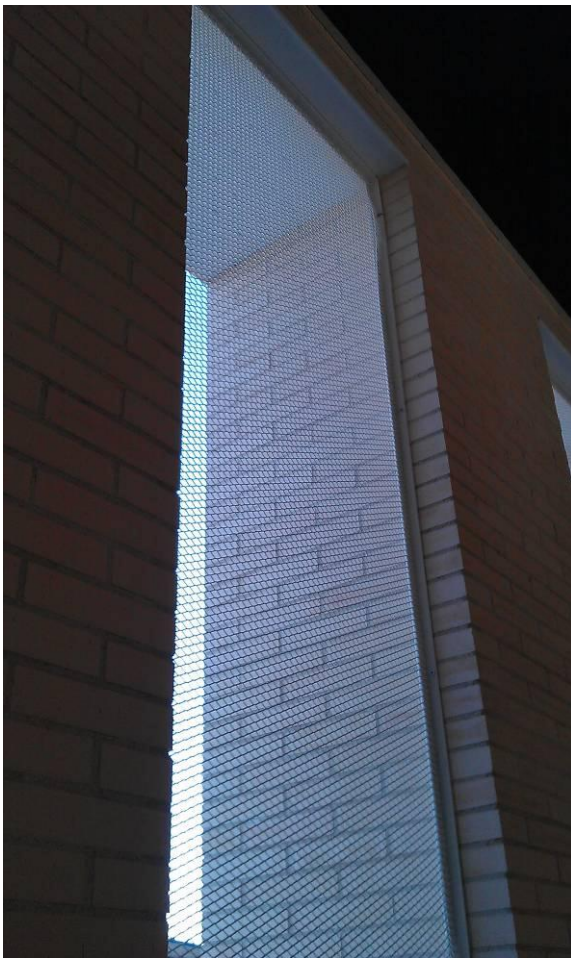
CERRAJERÍA DEPLOYÉ COLOCADA EN PLANTA BAJA, EN ZONA DE SOPORTALES)
