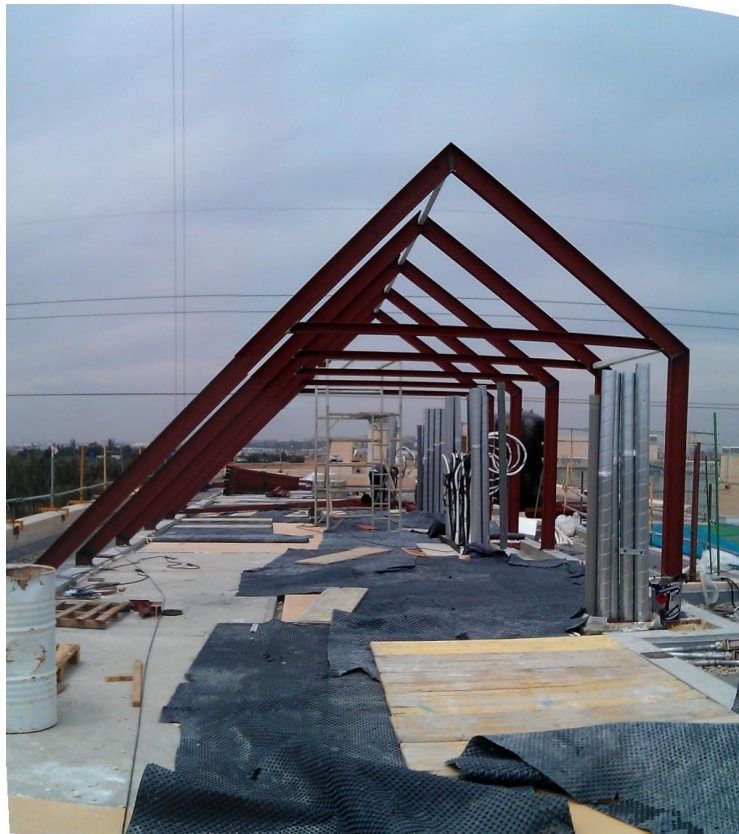
TRABAJOS DE ESTRUCTURA EN CUARTO DE CALDERAS DE CUBIERTA
