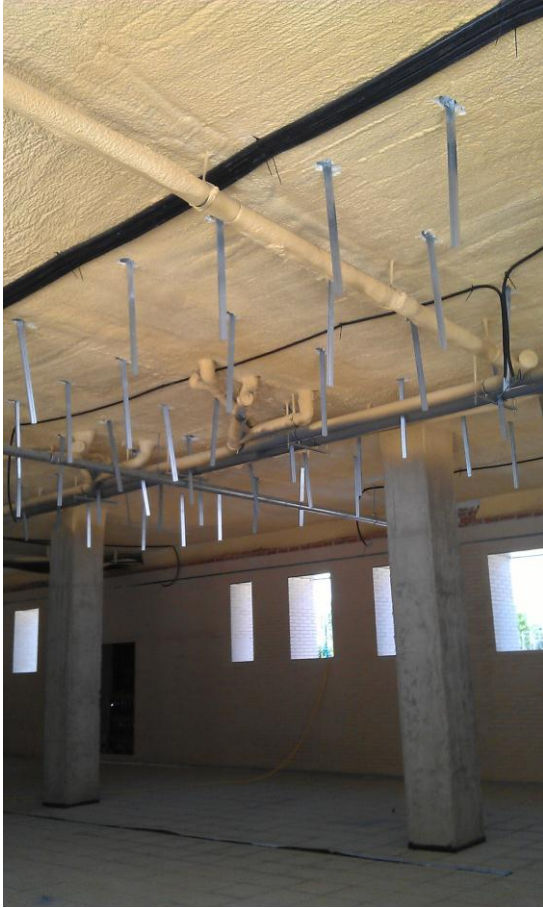
PRIMEROS TRABAJOS DE COLOCACIÓN DE FALSO TECHO EN SOPORTALES DE PLANTA BAJA. TRABAJOS DE LIMPIEZA DE HORMIGÓN VISTO EN PANTALLAS DE ESCALERAS DE PORTALES
