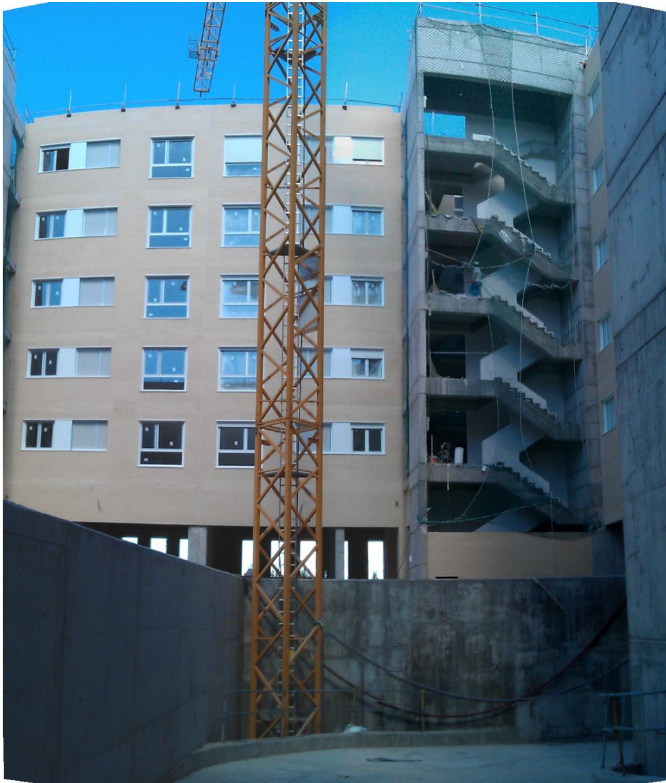
VISTA GENERAL DE FACHADA INTERIOR DESDE RAMPA DE GARAJE
