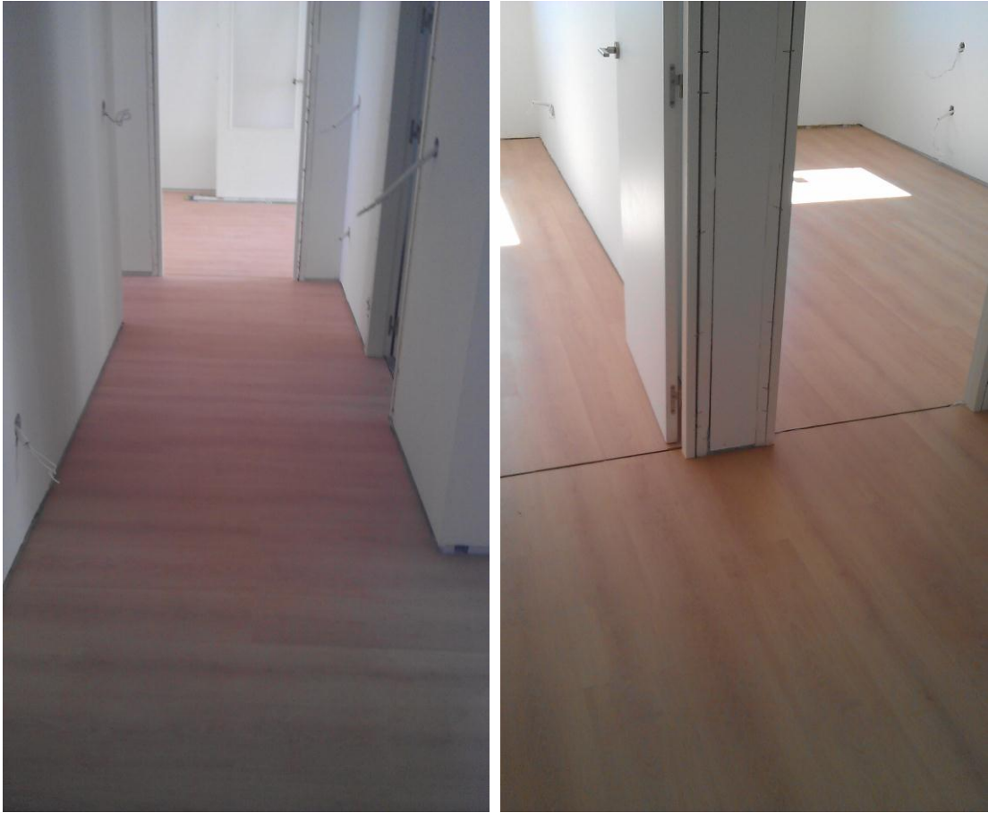
TRABAJOS DE COLOCACIÓN DE TARIMA DE MADERA EN VIVIENDAS
