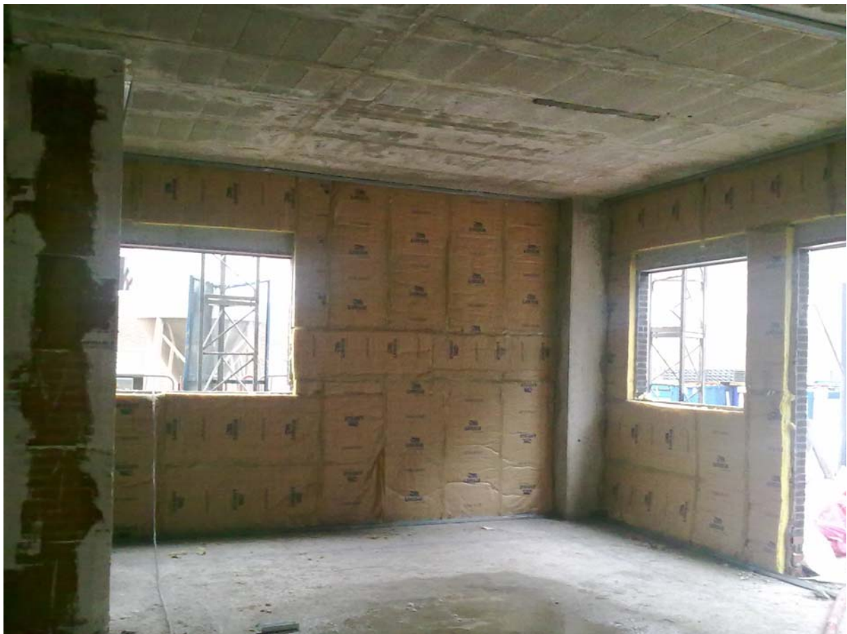
AISLAMIENTO TRASDOSADO CÁMARAS
