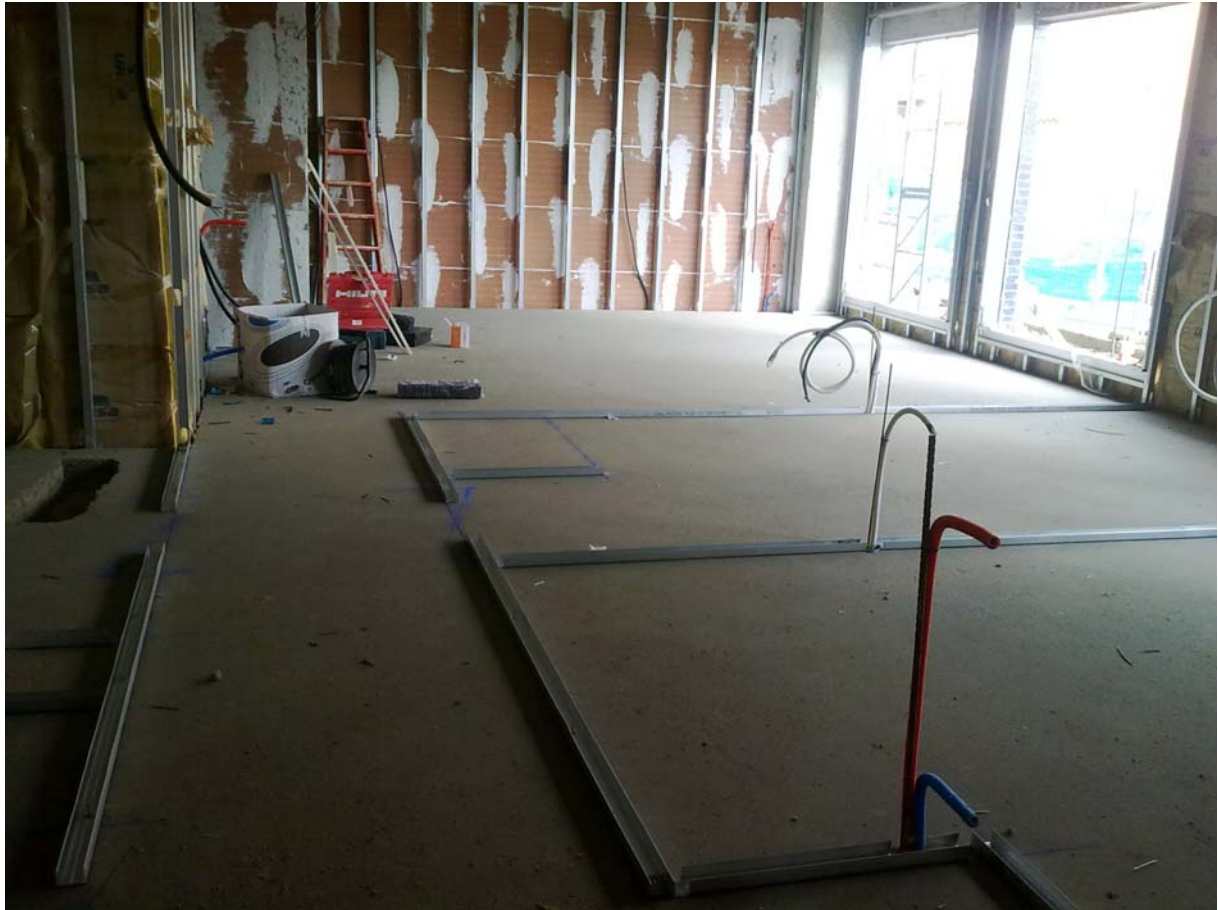
TABIQUERÍA INTERIOR DE PLADUR. INSTALACIONES
