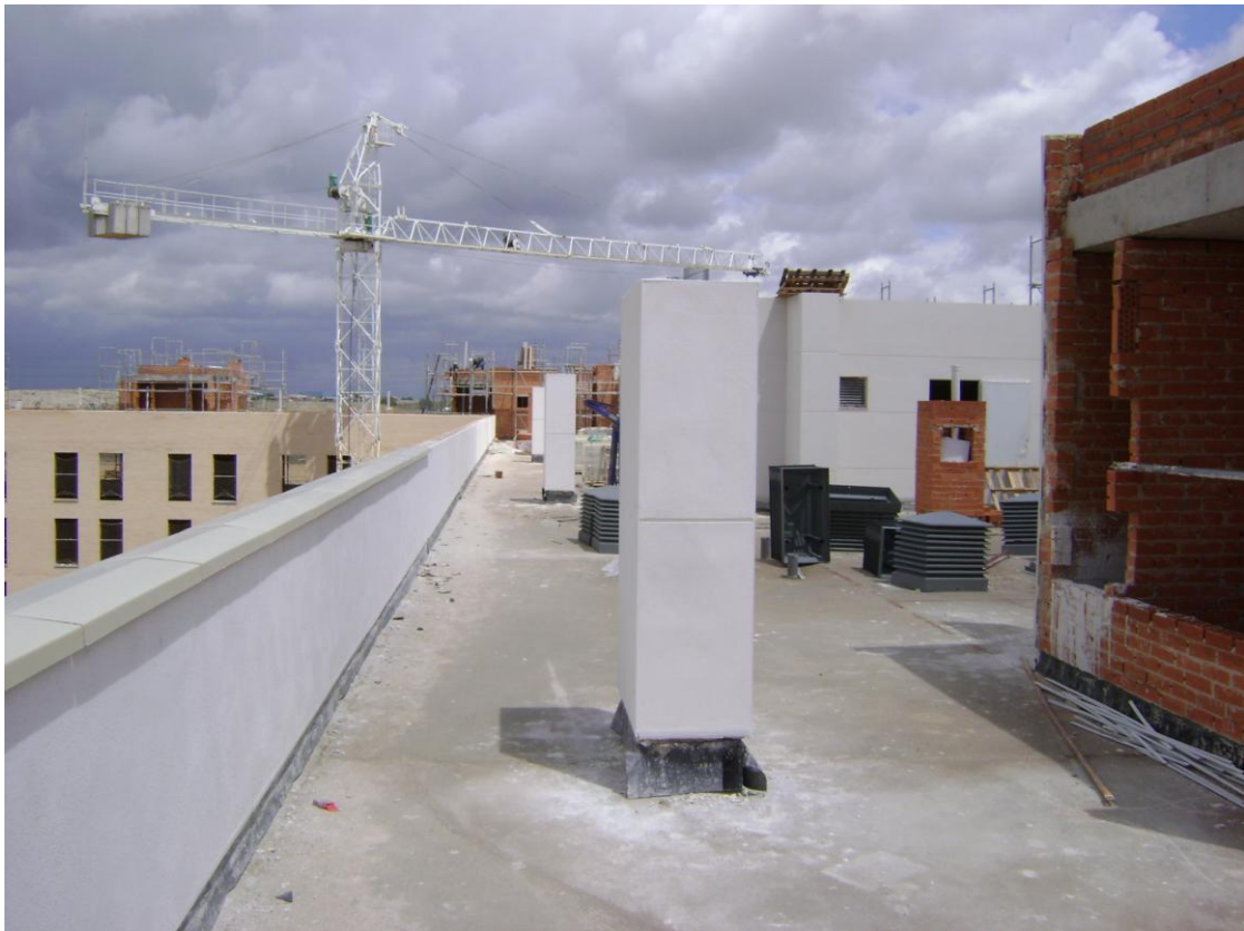
EJECUCION DE MONOCAPA EN TORREONES DE CUBIERTA
