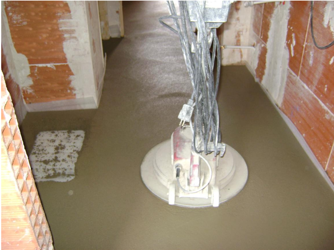
EJECUCION DE RECRECIDOS EN VIVIENDAS
