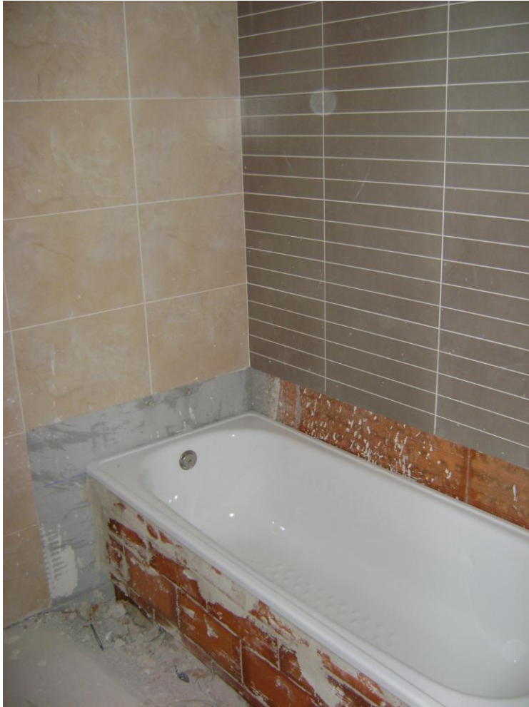
COLOCACION DE BANERAS Y ALICATADOS
