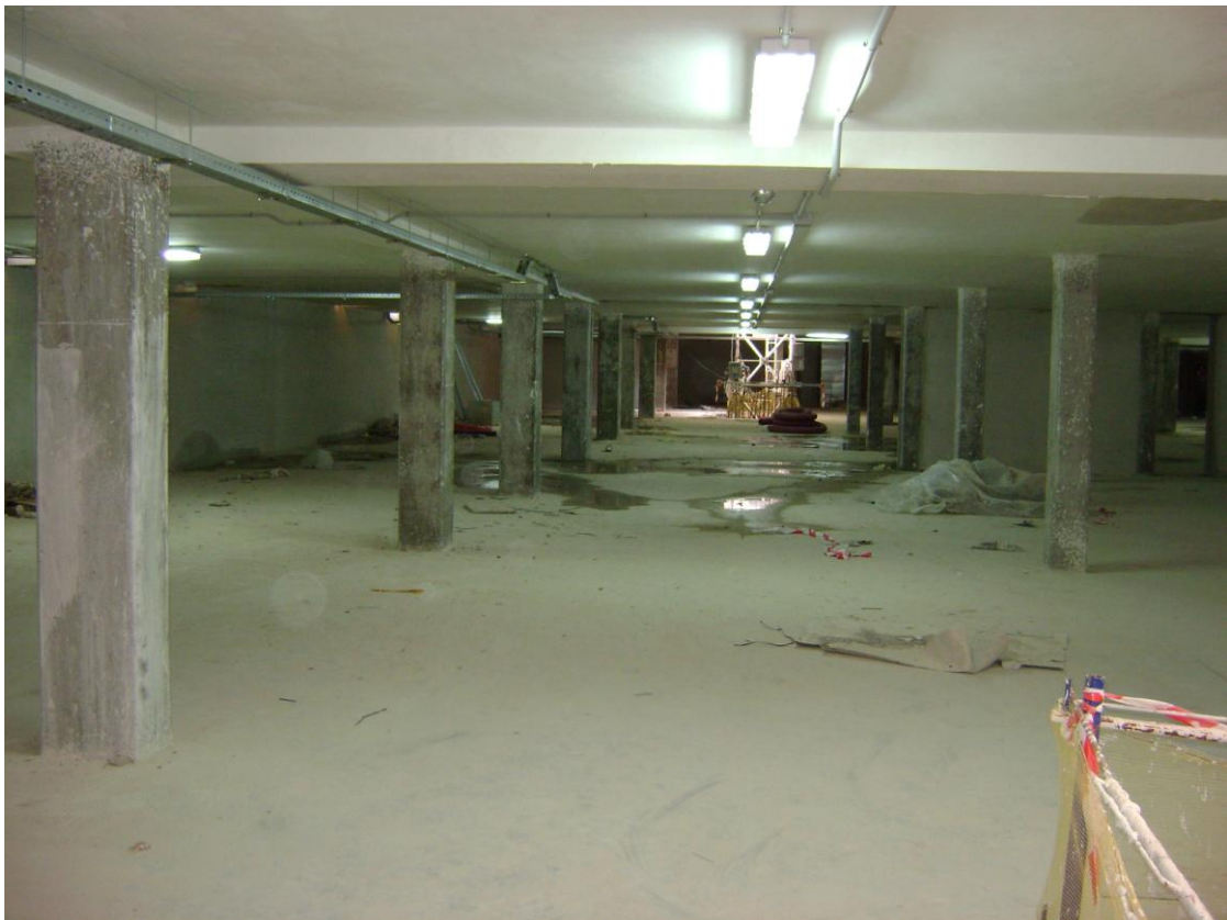
EJECUCION DE ILUMINACION EN GARAJES
