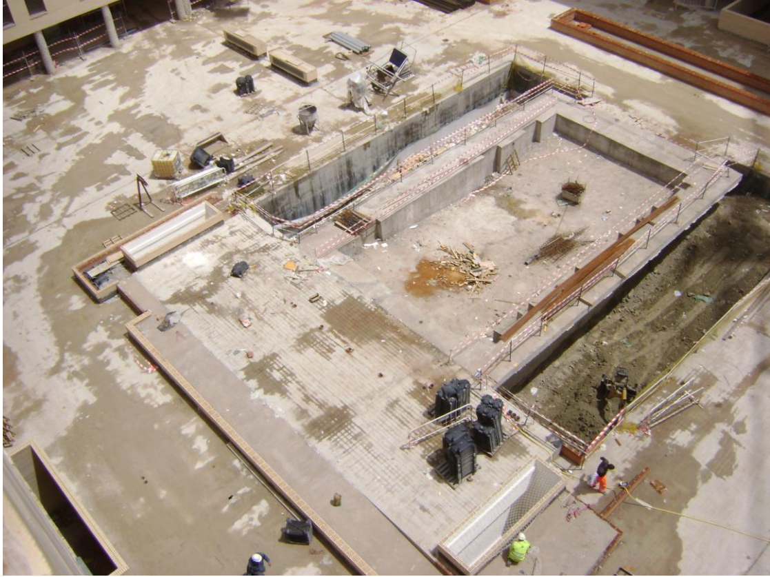
TRABAJOS DE EJECUCION EN PLAZA CENTRAL
