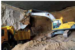
Introducción de la armadura en la pantalla de la estación de la Avenida de los Deportes. A la derecha, excavación para la ejecución de la pila-pilote. Debajo, excavación bajo la A-5 en la estación de Navalcarnero según el método constructivo de Minjira.
