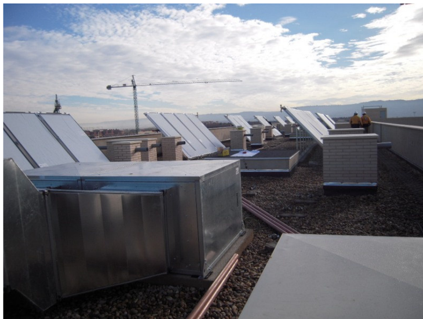
VISTA PLANTA DE CUBIERTA CON PANELES SOLARES
