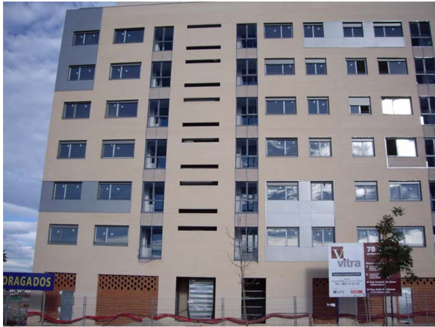
VISTA EXTERIOR FACHADA PORTAL 5
