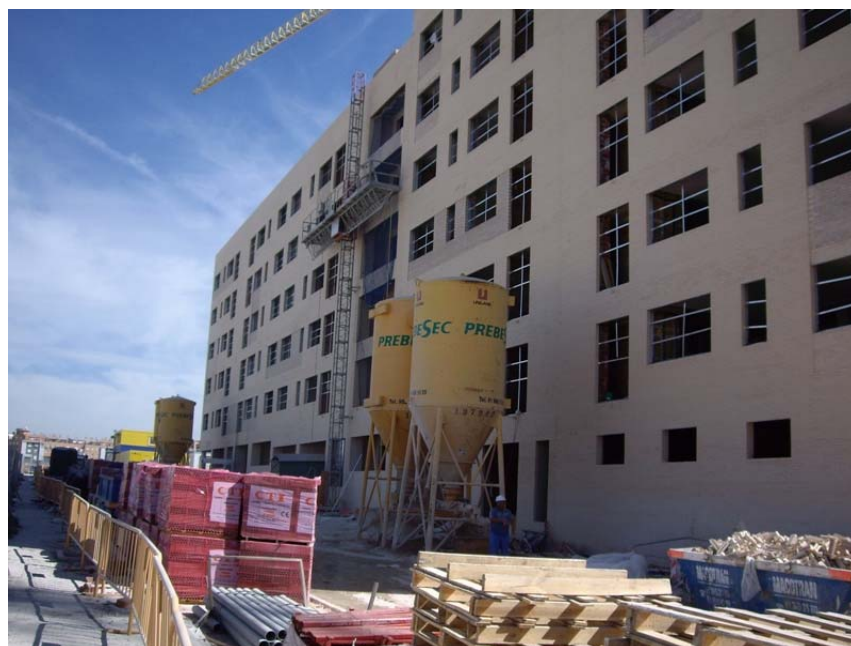
VISTA EXTERIOR FACHADA DE LOS PORTALES 3 Y 4
