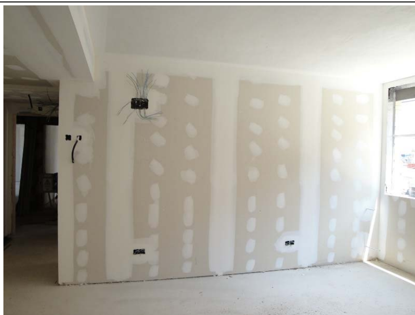
VISTA INTERIOR VIVIENDA. PLADUR.
