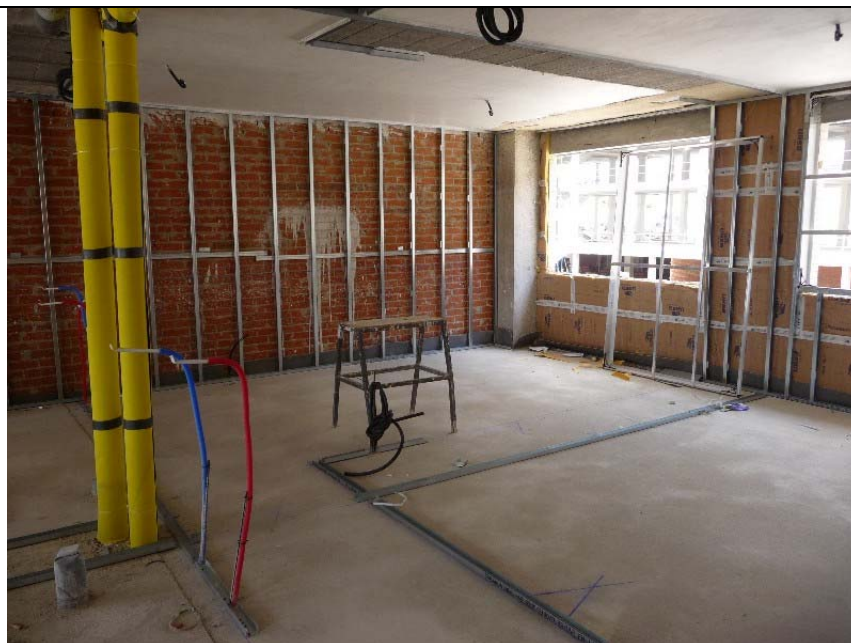
VISTA INTERIOR VIVIENDA.
