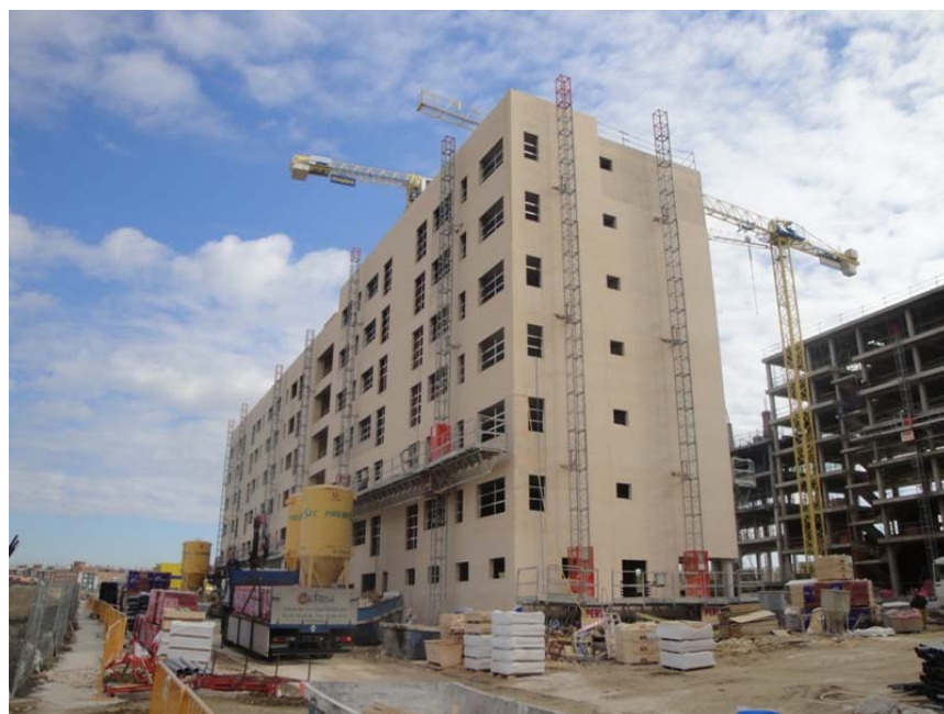
VISTA EXTERIOR PORTAL 6
