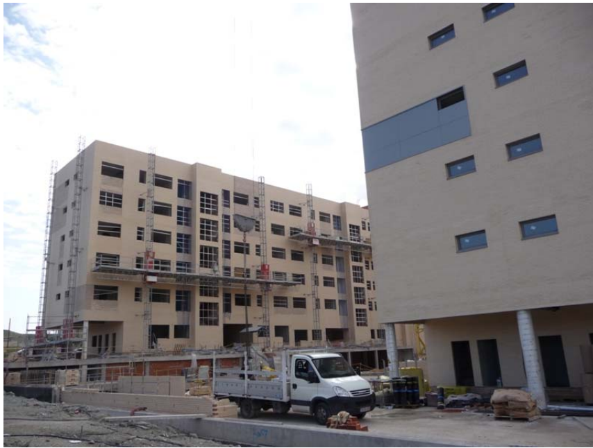
VISTA INTERIOR FACHADA DE LOS PORTALES 1 Y 2
