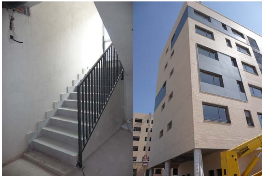
VISTA ESCALERA PORTAL. VISTA FACHADA EXTERIOR PORTAL 3
