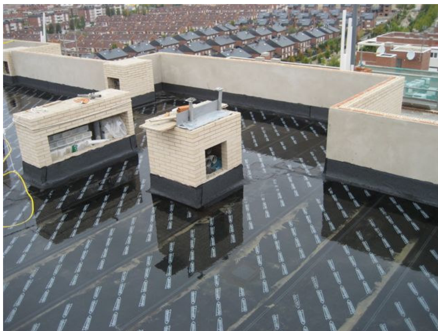
IMPERMEABILIZACION DE CUBIERTAS
