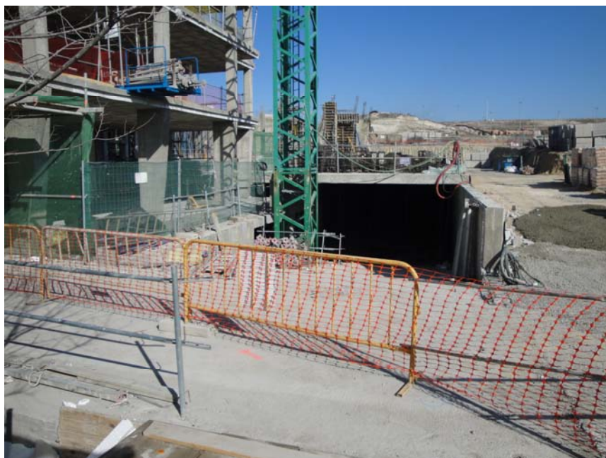
VISTA ENTRADA ACCESO GARAJE
