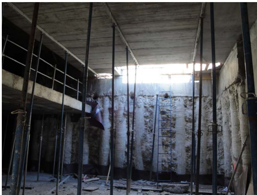
VISTA INTERIOR DEL GARAJE
