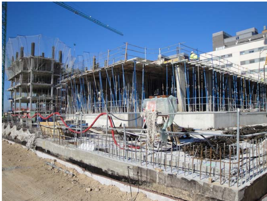
VISTA INTERIOR DEL PORTAL 1 Y 3
