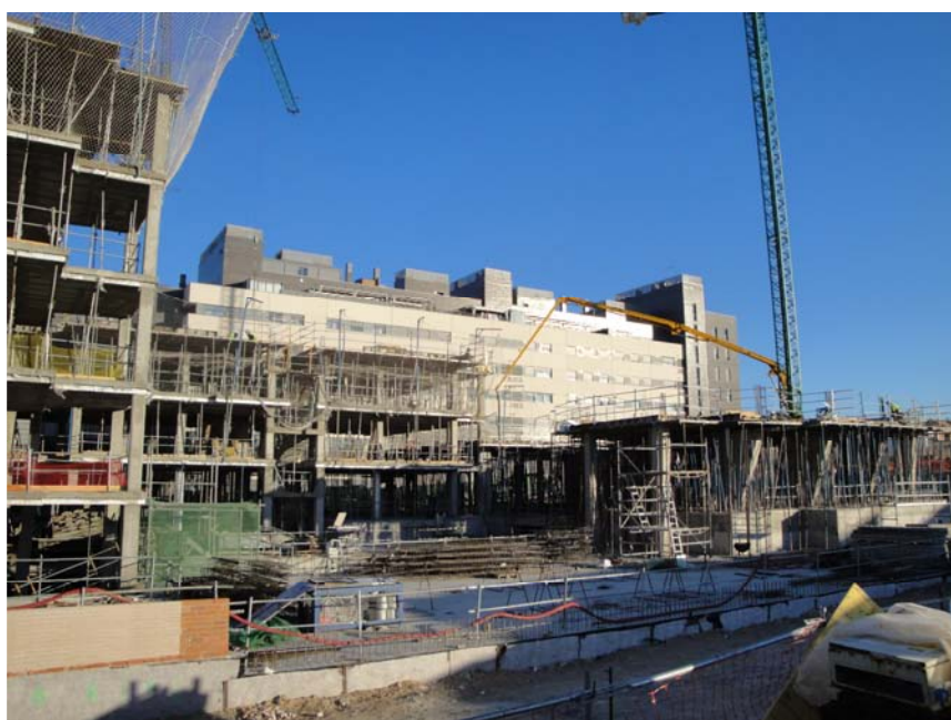
VISTA INTERIOR DEL PORTAL 2 Y 3
