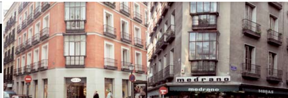
30 viviendas. Calle Fuencarral 90. CENTRO.
