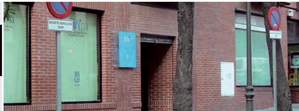
Sede del Servicio de Inspección de Viviendas de Madrid (SIVIM).
