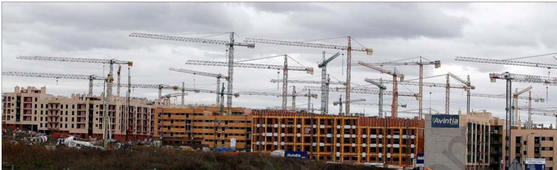
Imagen de esta semana de viviendas en construcción en uno de los nuevos desarrollos de Getafe. / JAVIER BARBANCHO
