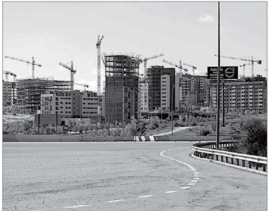
Imagen tomada a finales de 2012 de obras en Valdebebas, uno de los desarrollos afectados. PABLO MONGE.
