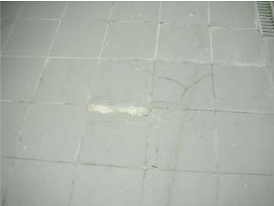
Juntas de dilatación levantadas, que están provocando que las baldosas se estén rompiendo
