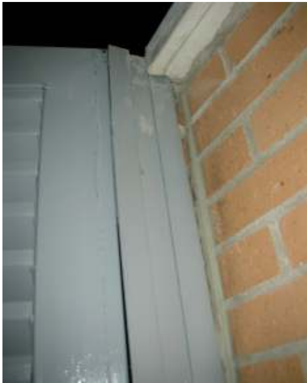
Detalles del marco de la puerta separado de la pared de ladrillo y también del ahucamiento de la chapa (en la foto de la izquierda)
