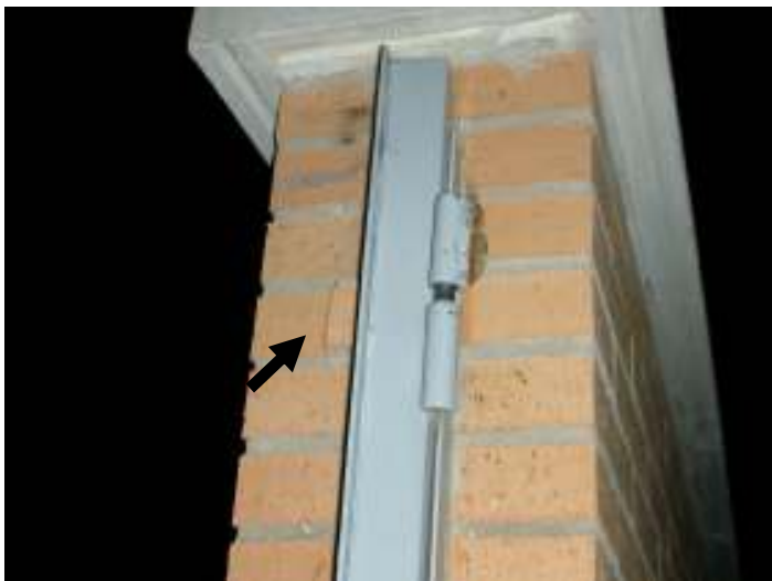
Se observa la bisagra superior arrancada de la puerta, así como un ladrillo semi-arrancado en la cuarta hilada, junto al marco de la puerta.
