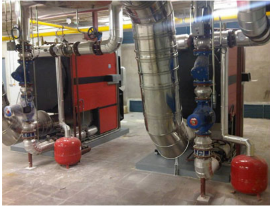
11_12_ Imagen de dos calderas ya instaladas. Archivo EMVS
