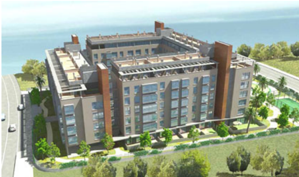
Vista general del edificio
