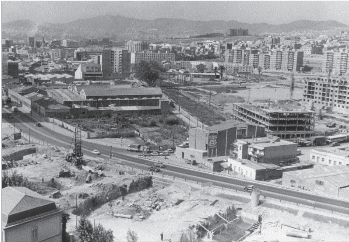
Aquesta fotografia, realitzada mentre es feien les obres de pilotatge de l'A-19, permet veure els primers blocs de pisos aixecats a Llefia. Museu de Badalona. Arxiu d'imatges. Fons Ajuntament de Badalona. Fotògraf: Carlos Pérez de Rozas.
