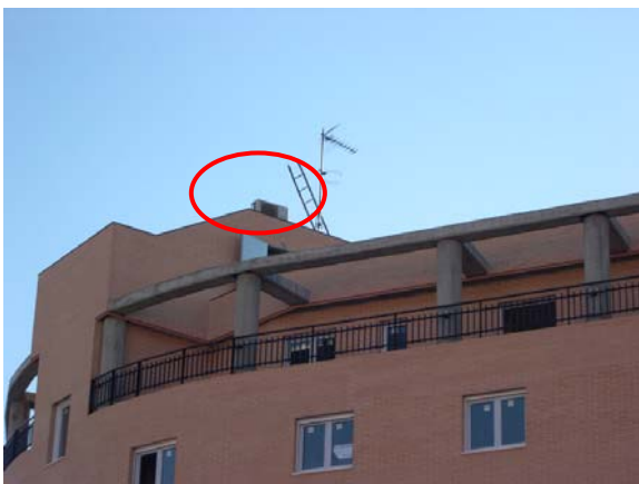
Vista de Máquina A/A encima de Casetón del ascensor. Vista Exterior
