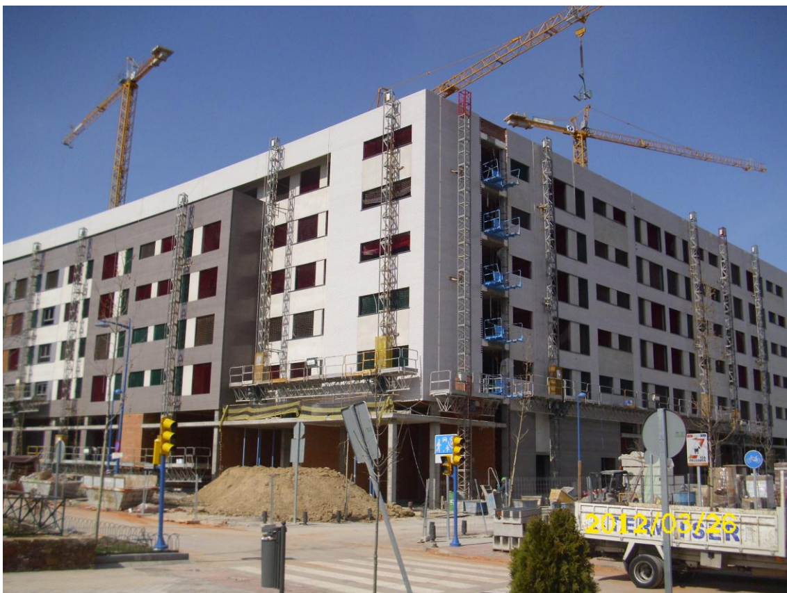
FACHADA EXTERIOR PORTALES 9, 10, 11, 12 y 1
