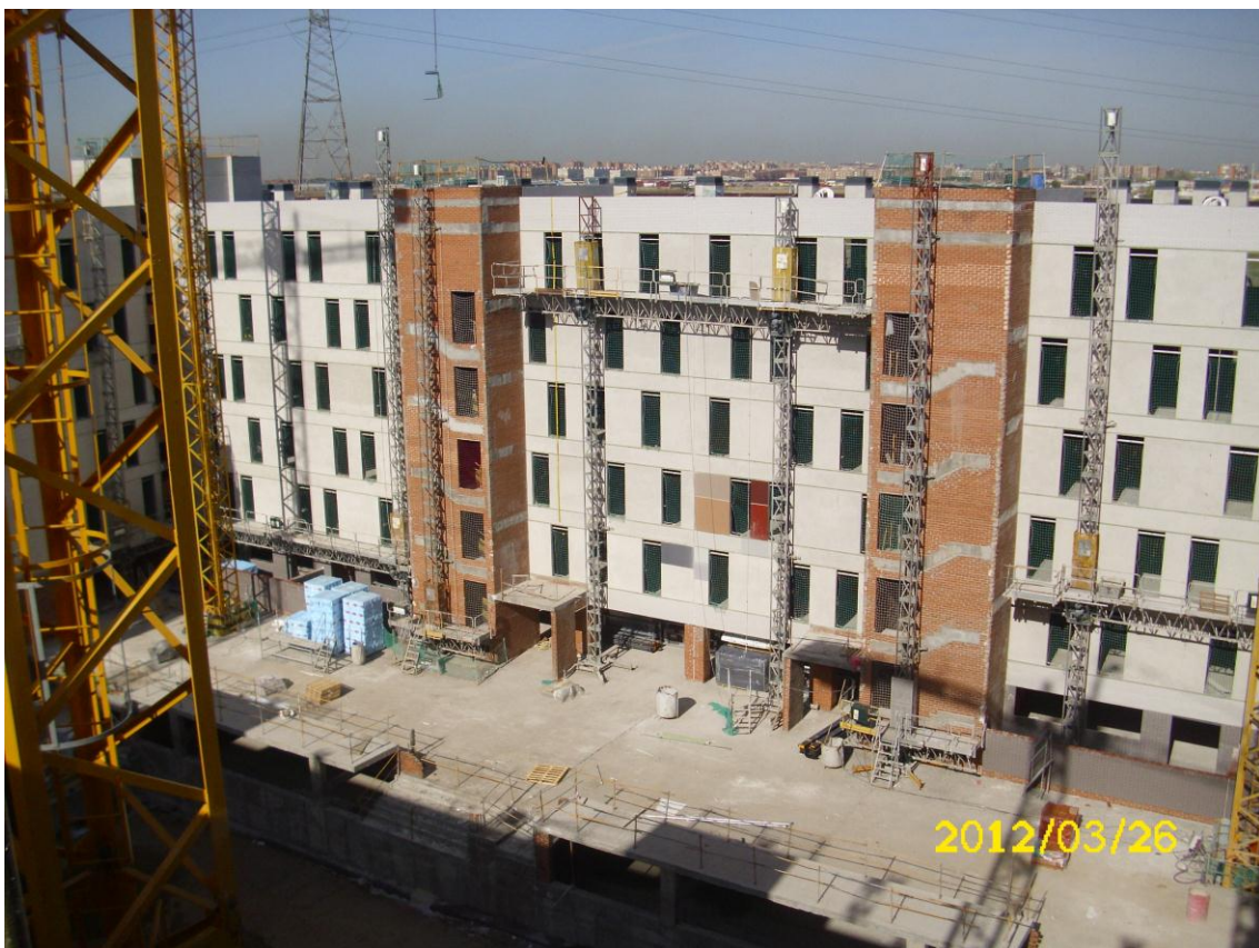
FACHADA INTERIOR PORTALES 5, 6 y 7
