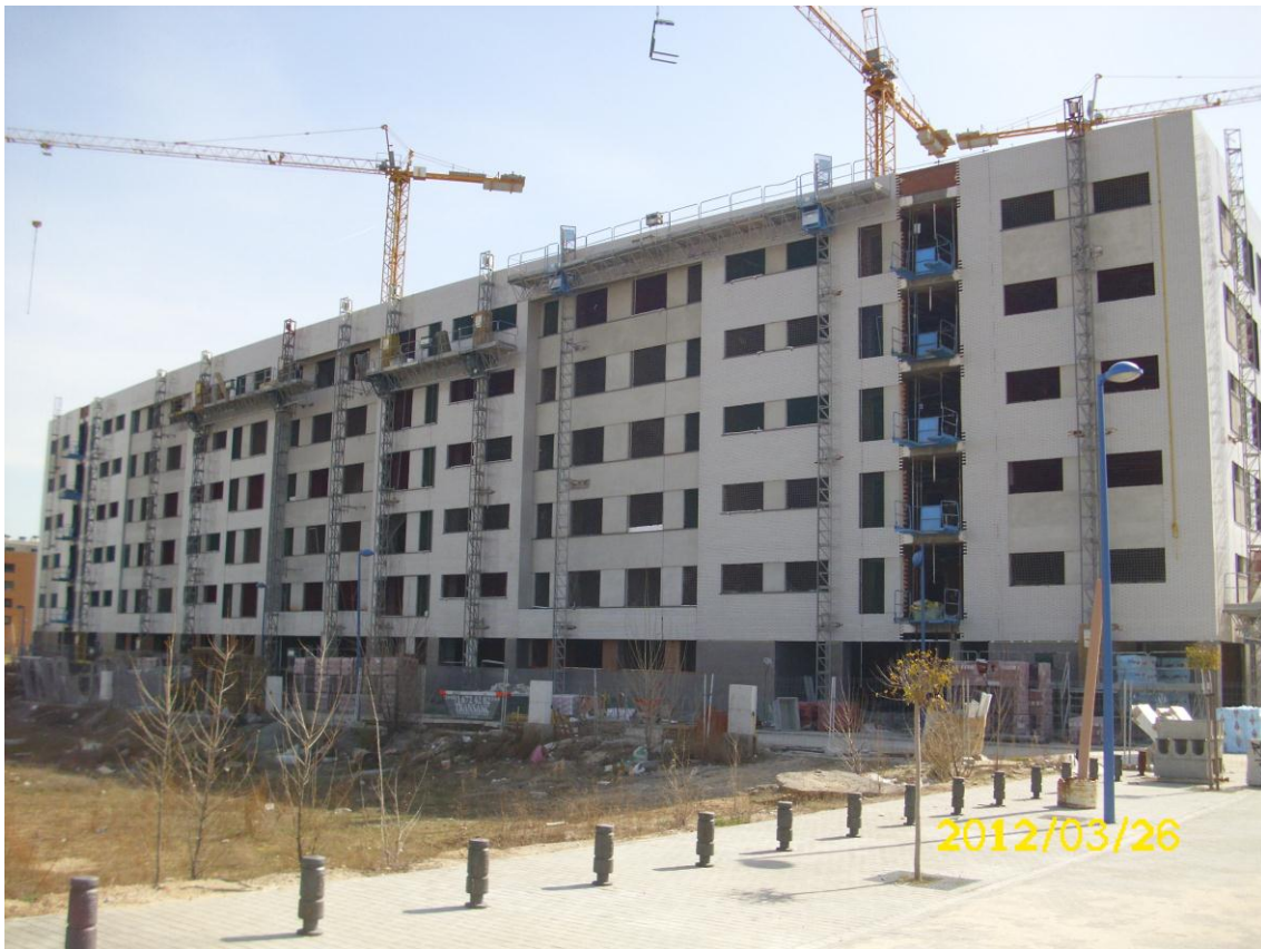
FACHADA EXTERIOR PORTALES 5, 6, 7 y 8
