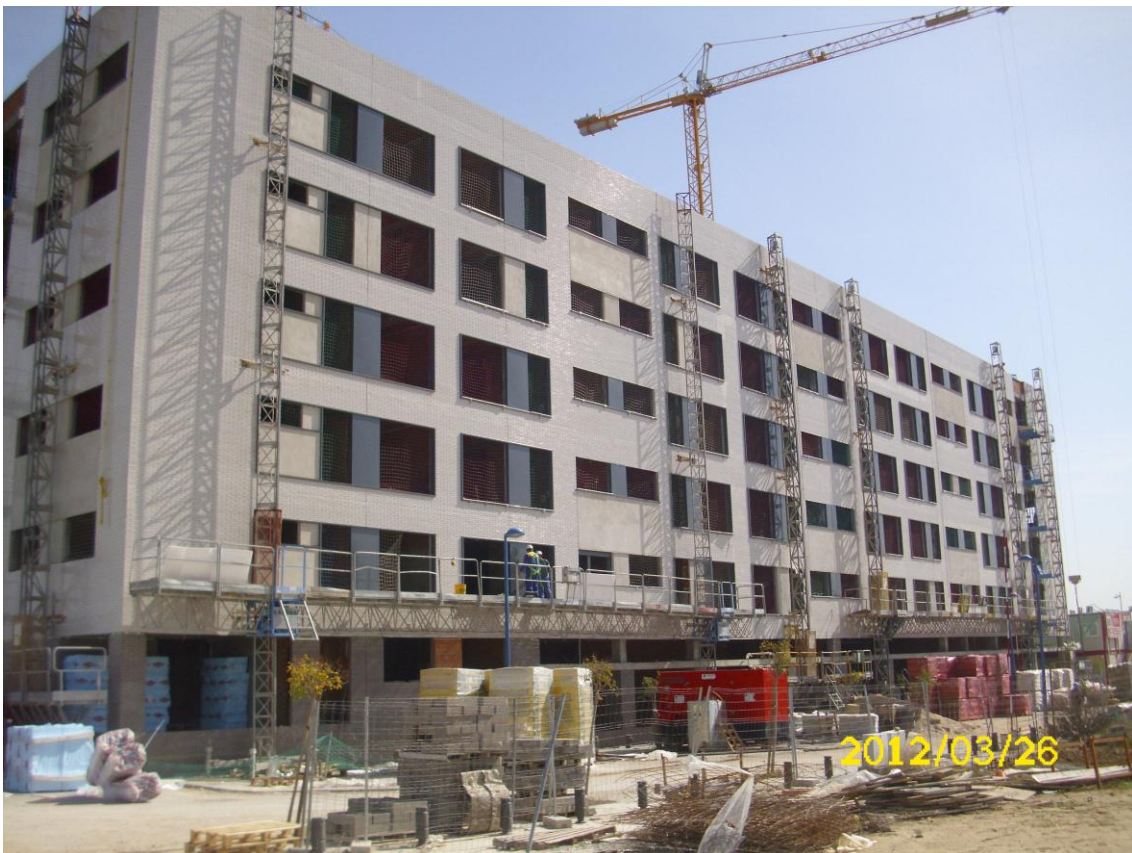
FACHADA EXTERIOR PORTALES 2, 3, 4 y 5
