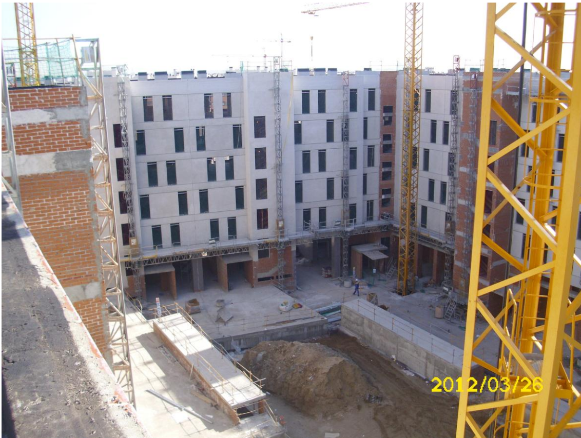
FACHADA INTERIOR PORTALES 9, 10 y 11
