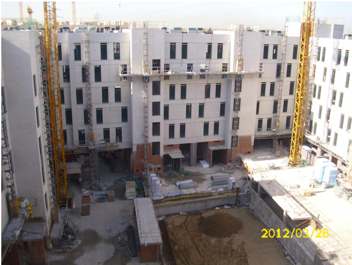
FACHADA INTERIOR PORTALES 2, 3, 4 y 5
