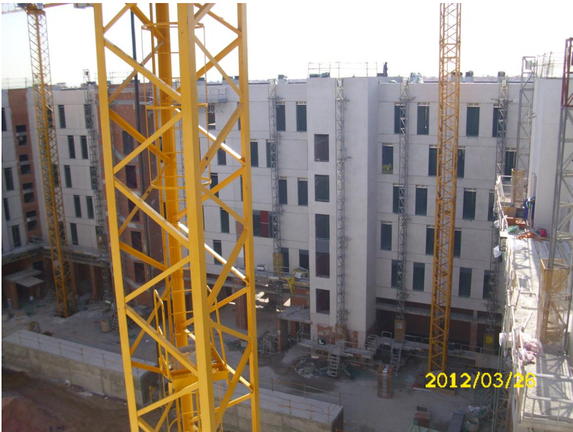
FACHADA INTERIOR PORTALES 12, 1 y 2
