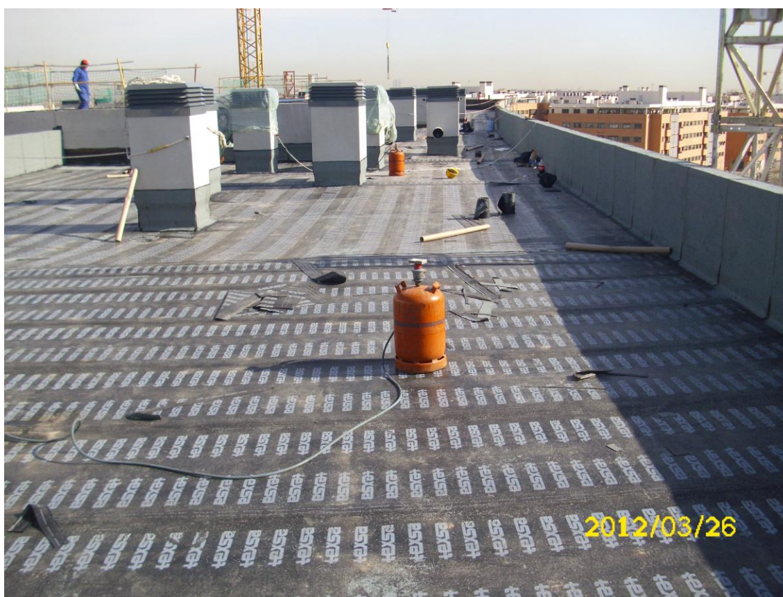
IMPERMEABILIZACIÓN DE CUBIERTAS Y REMATES DE CHIMENEAS
