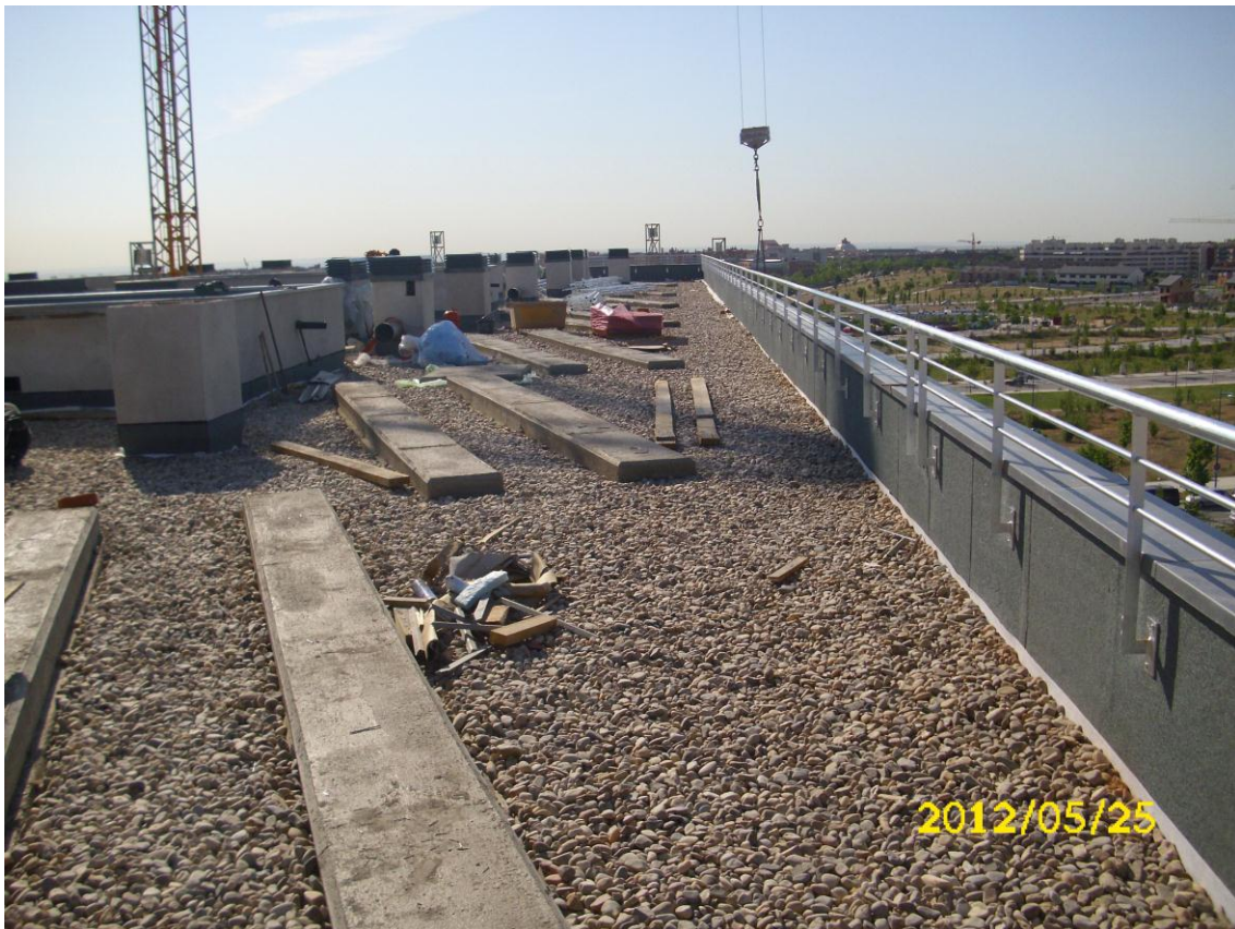
AISLAMIENTO, PAVIMENTO, BANCADAS Y BARANDILLA DE CUBIERTAS
