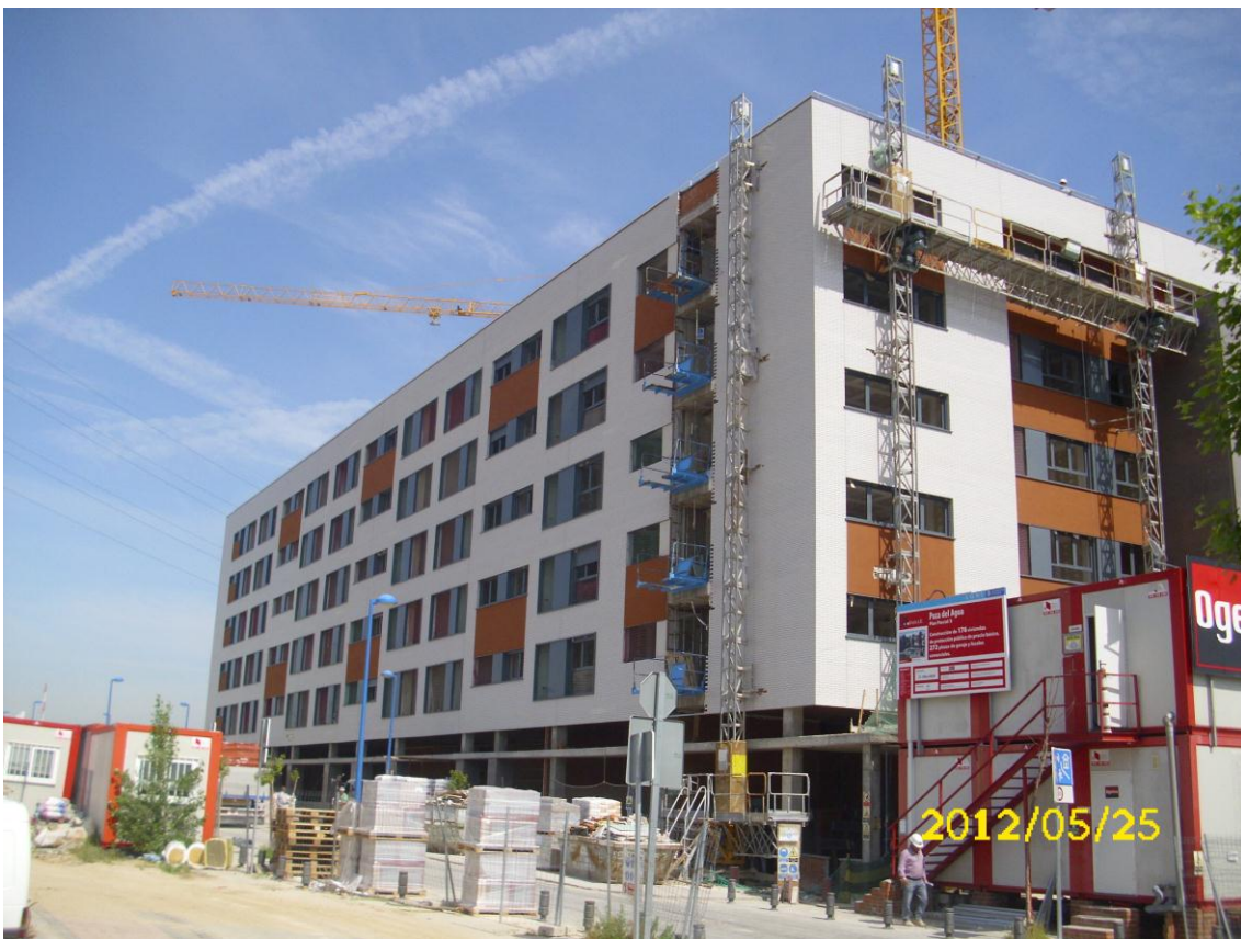
FACHADA EXTERIOR PORTALES 2,3, 4 Y 5
