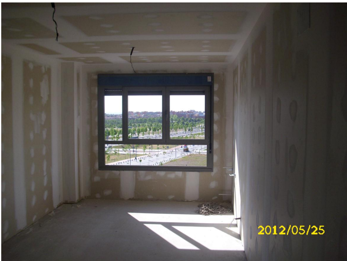
TABIQUERIA Y FALSOS TECHOS VIVIENDAS
