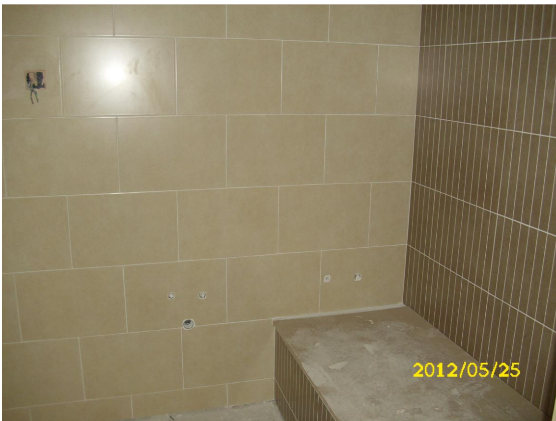
ALICATADO BAÑO PRINCIPAL
