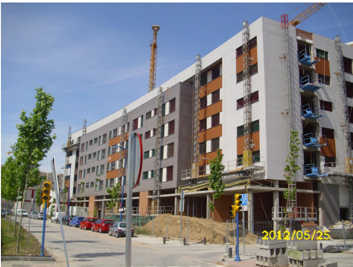
FACHADA EXTERIOR PORTALES 11, 12, 1 Y 2
