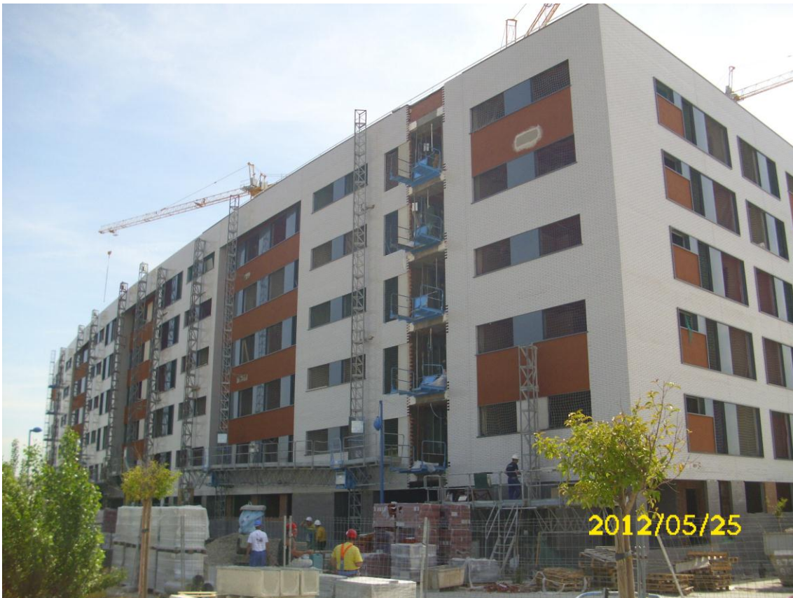
FACHADA EXTERIOR PORTALES 5, 6, 7 Y 8
