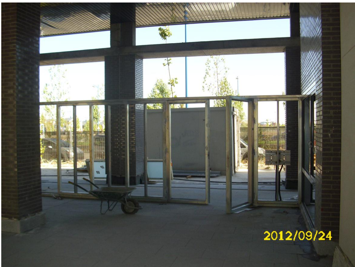
TRABAJOS DE CERRAJERÍA EN ACCESO PRINCIPAL.
