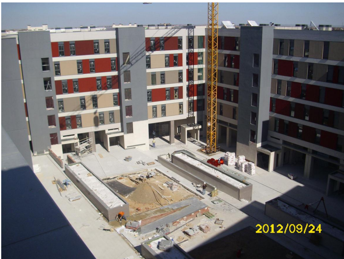
FACHADA INTERIOR Y URBANIZACIÓN INTERIOR, PORTALES 9, 10, 11 Y 12
