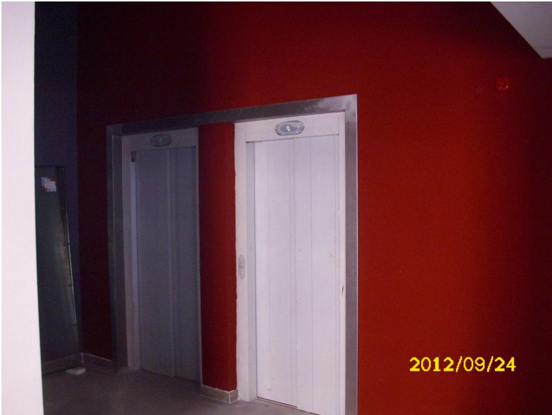
VESTIBULO PLANTA BAJA, PORTAL 1
