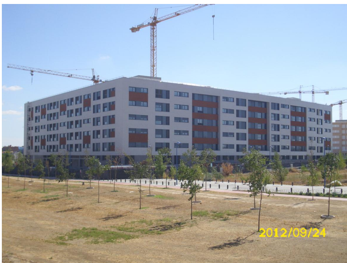
FACHADA EXTERIOR PORTALES 12, 1, 2, 3, 4 Y 5
