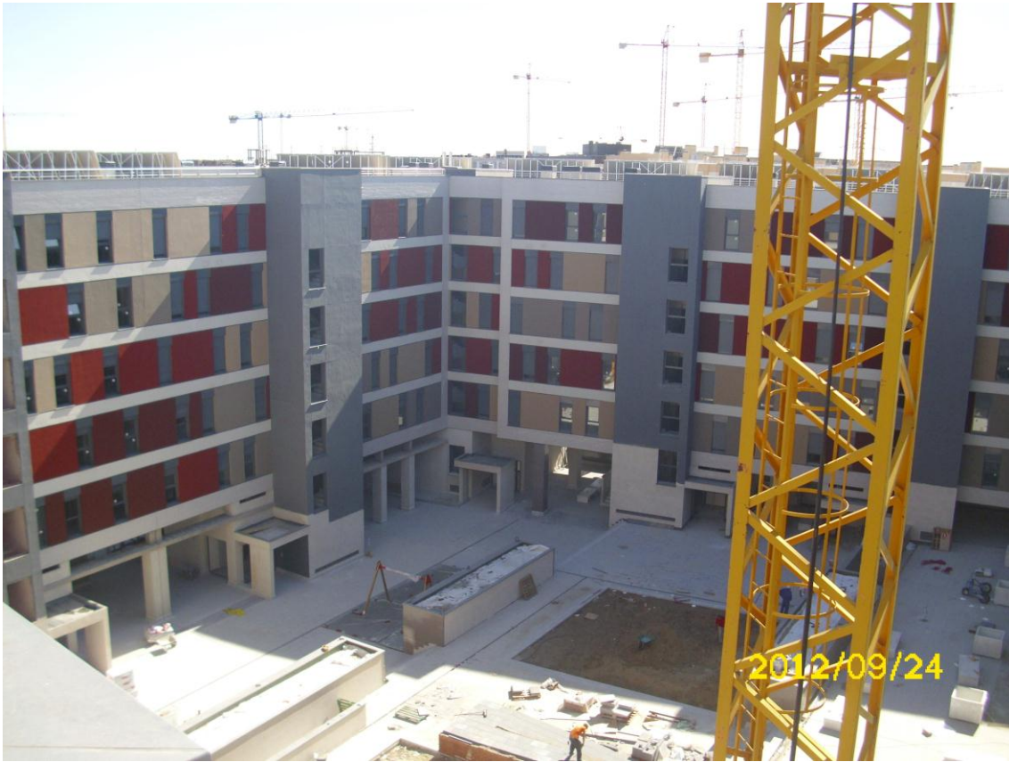
FACHADA INTERIOR Y URBANIZACIÓN INTERIOR, PORTALES 12, 1, 2, 3 Y 4
