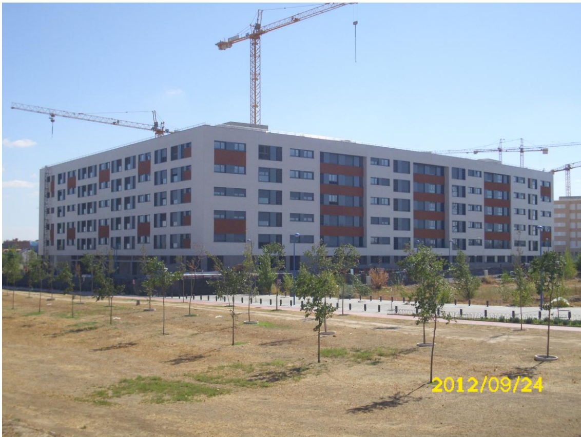
FACHADA EXTERIOR PORTALES 5, 6, 7, 8, 9, 10 Y 11
