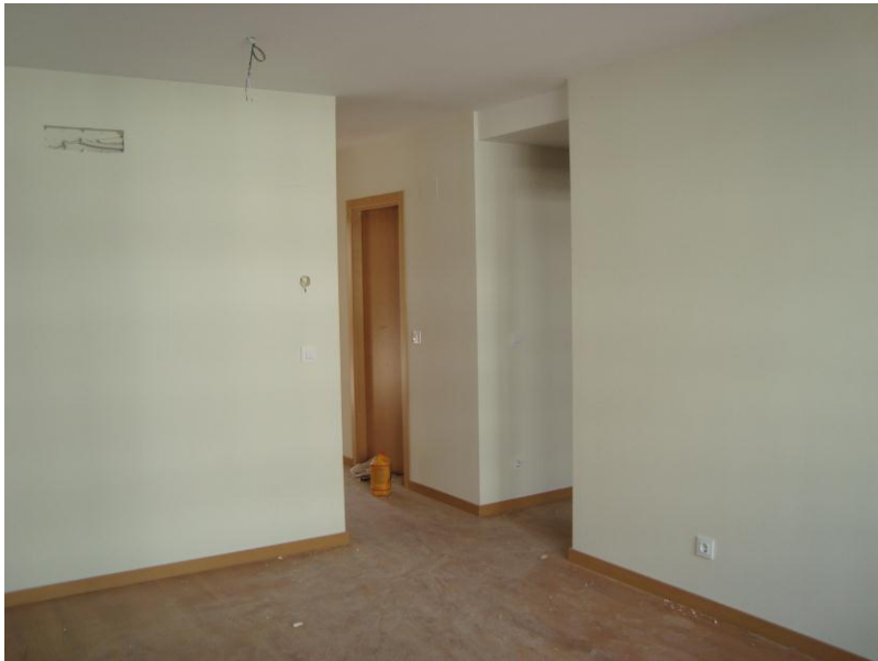
ASPECTO GENERAL INTERIOR VIVIENDA
