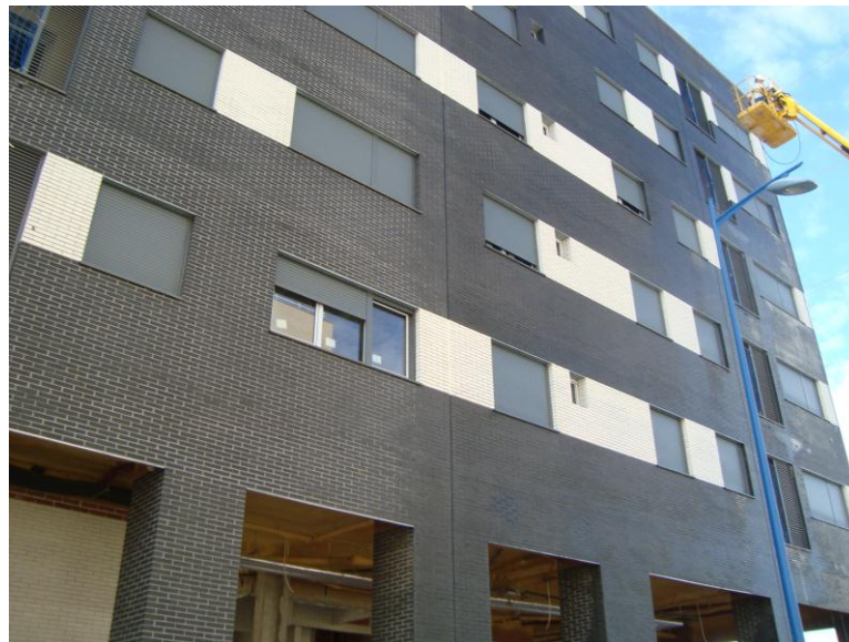
LIMPIEZA FACHADA EXTERIOR
