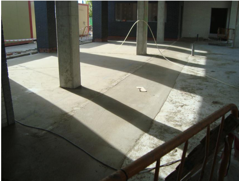
INCIO FORMACION DE PENSDIETES PARA IMPERMEABILIZACIÓN CUBIERTA GARAJE
