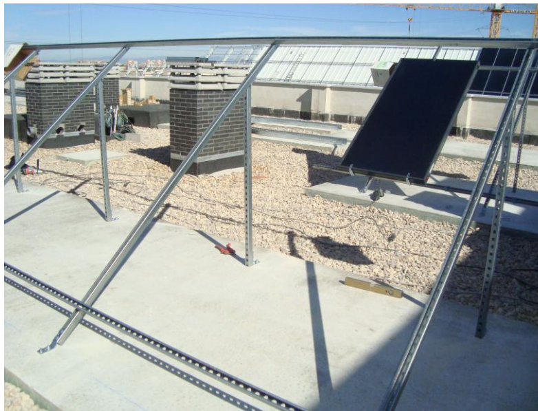
COMIENZO COLOCACION PANELES SOLARES
