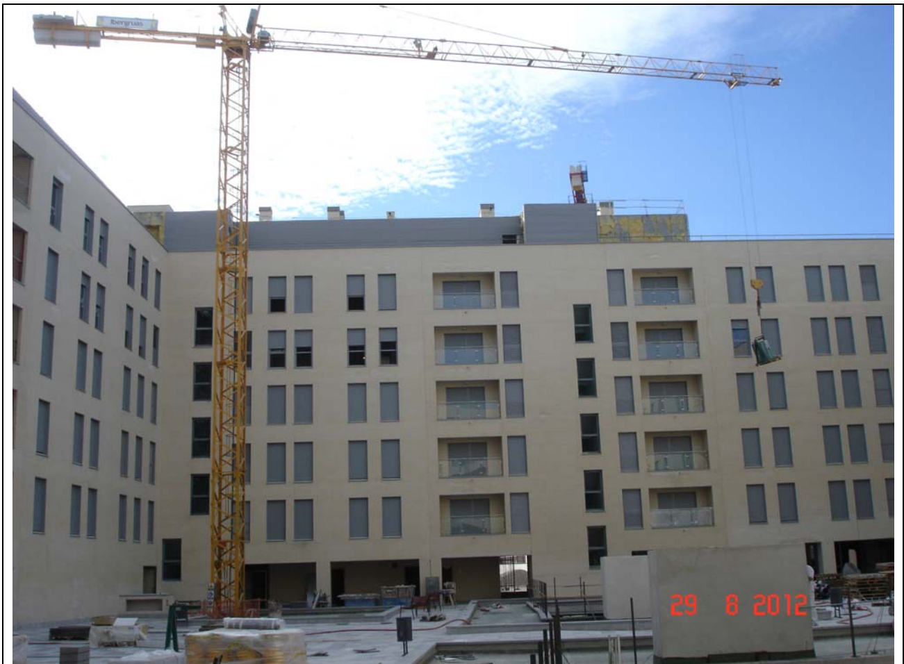
Vista general fachada interior.
