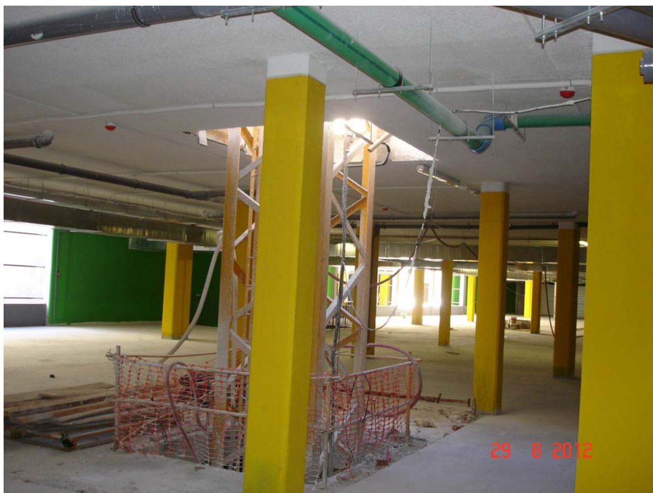
Vista interior garaje, comienzo de pintura sótano primero.
