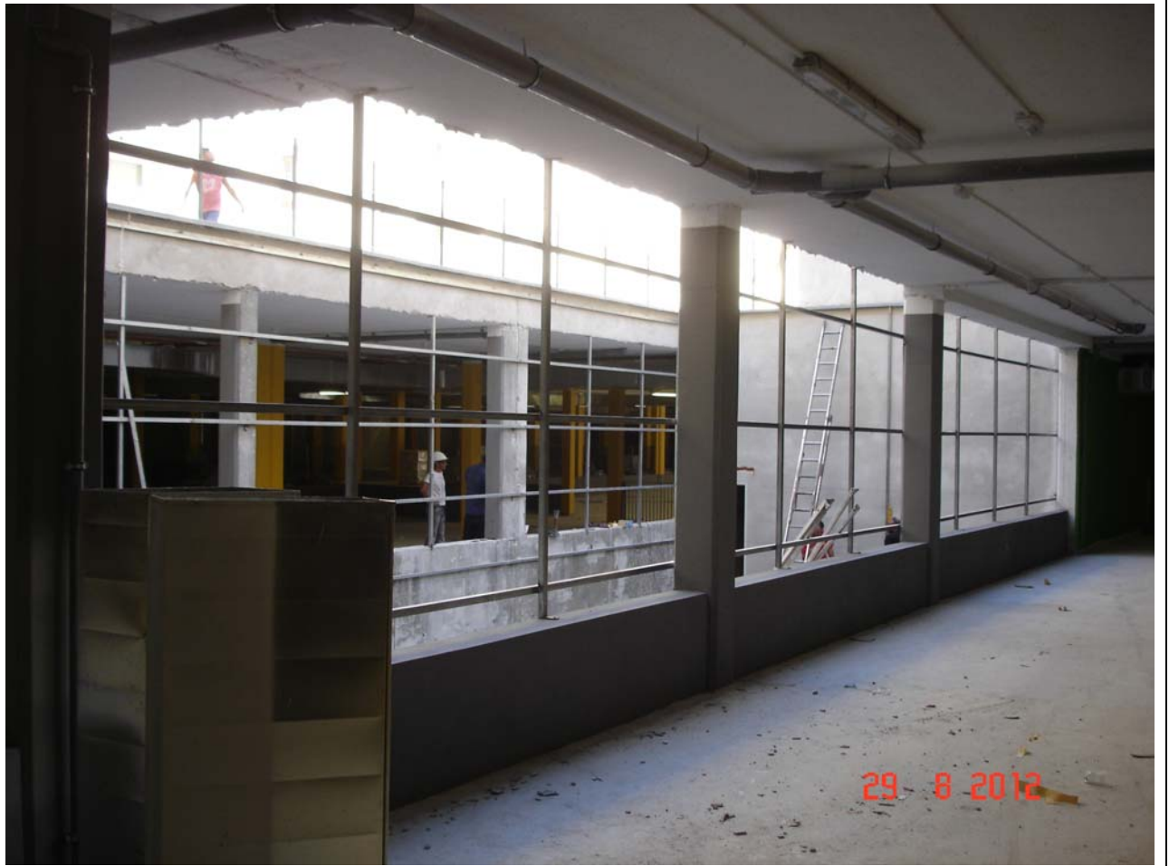
Vista interior patio garaje.
