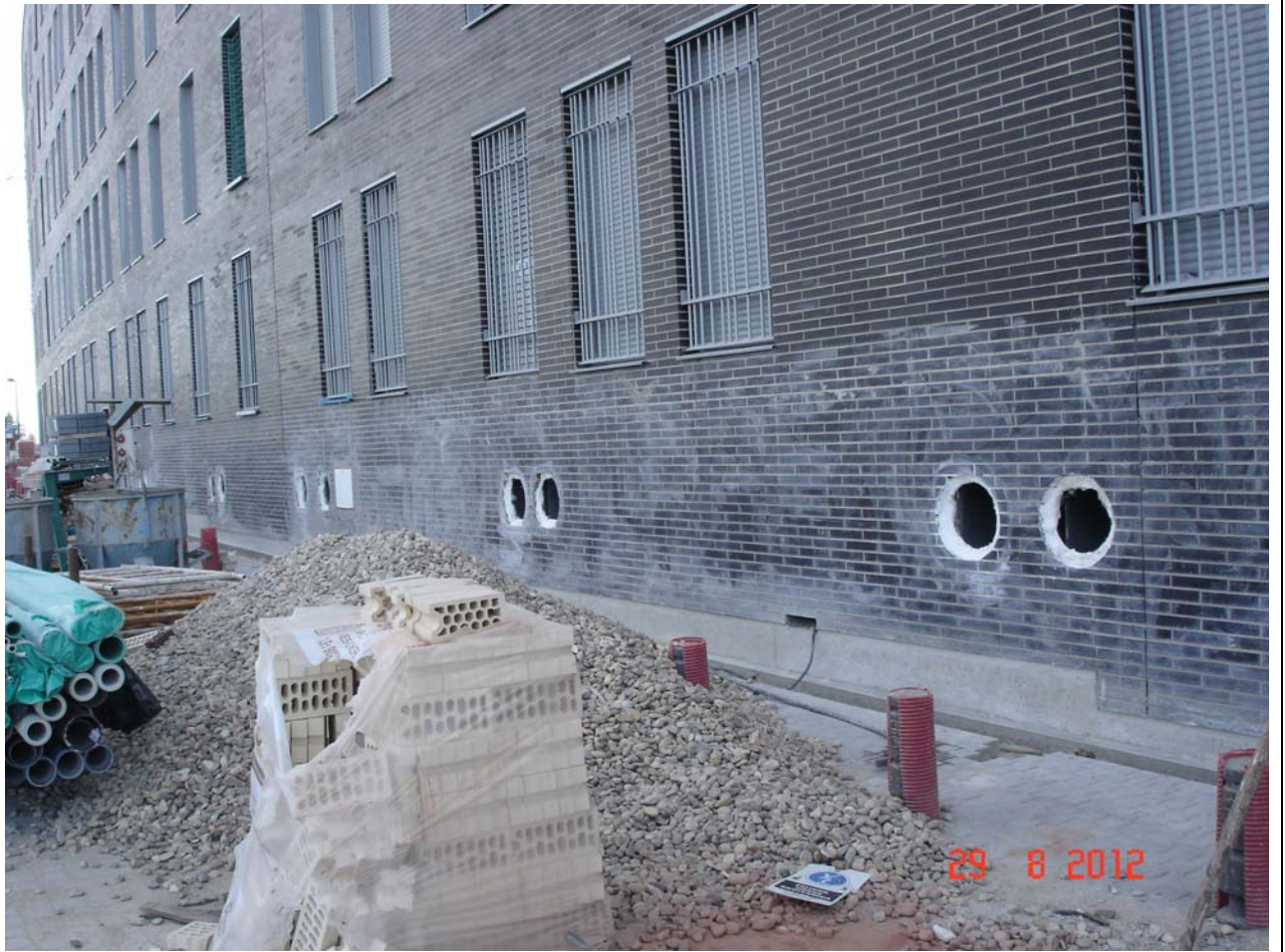
Embocaduras rejillas de ventilación en fachada.
