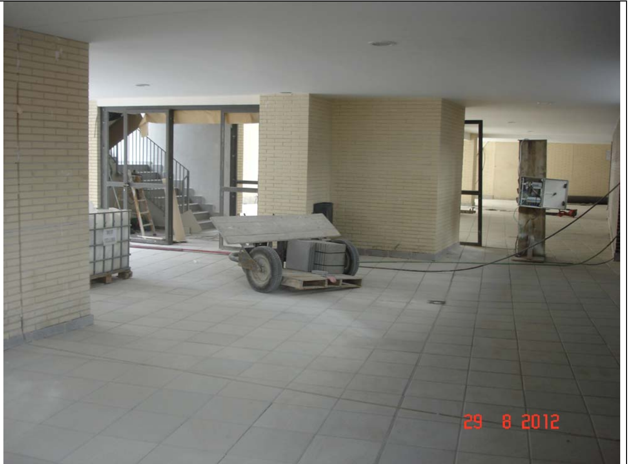
Soportales estado actual.
