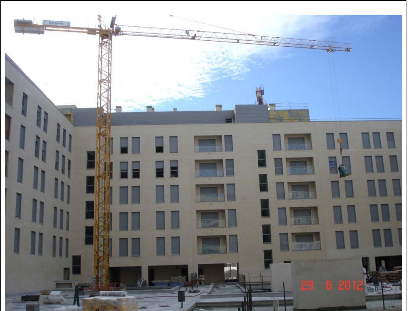
Patio interior estado general.
