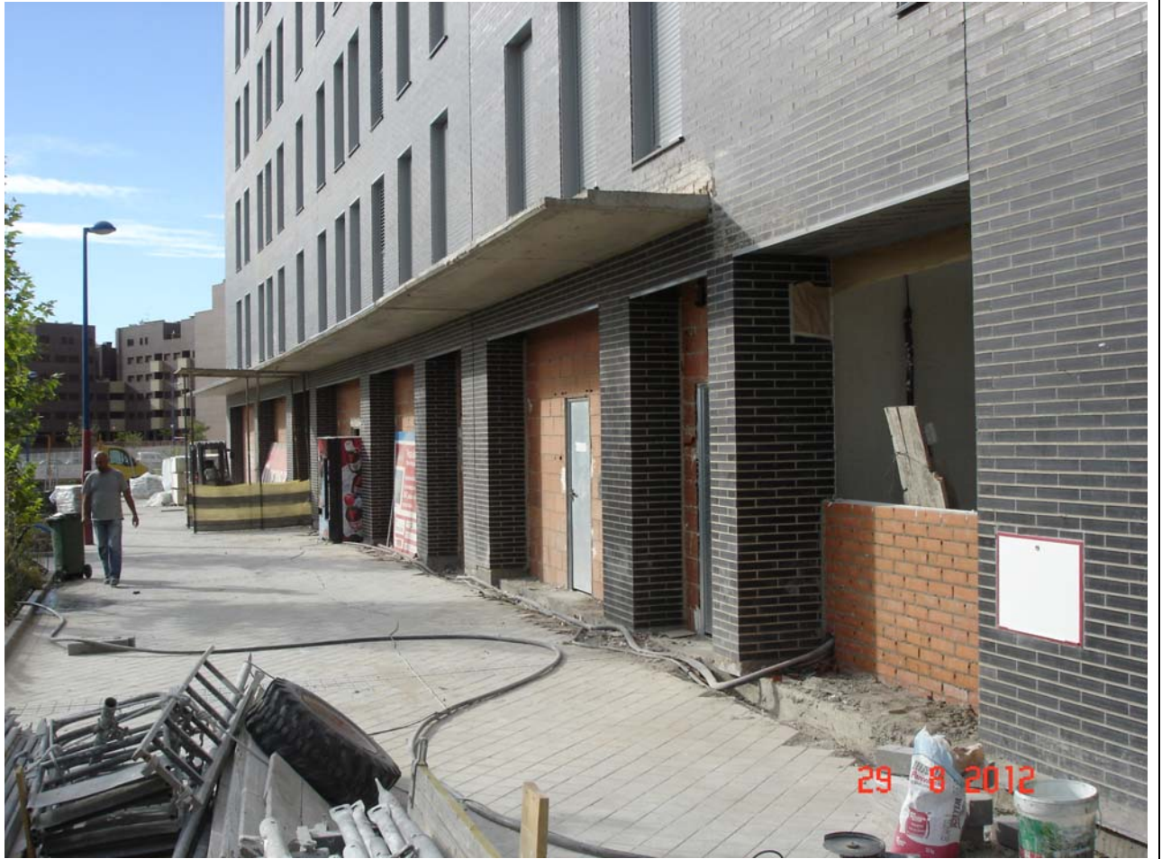
Vista fachada locales y conserjería.
