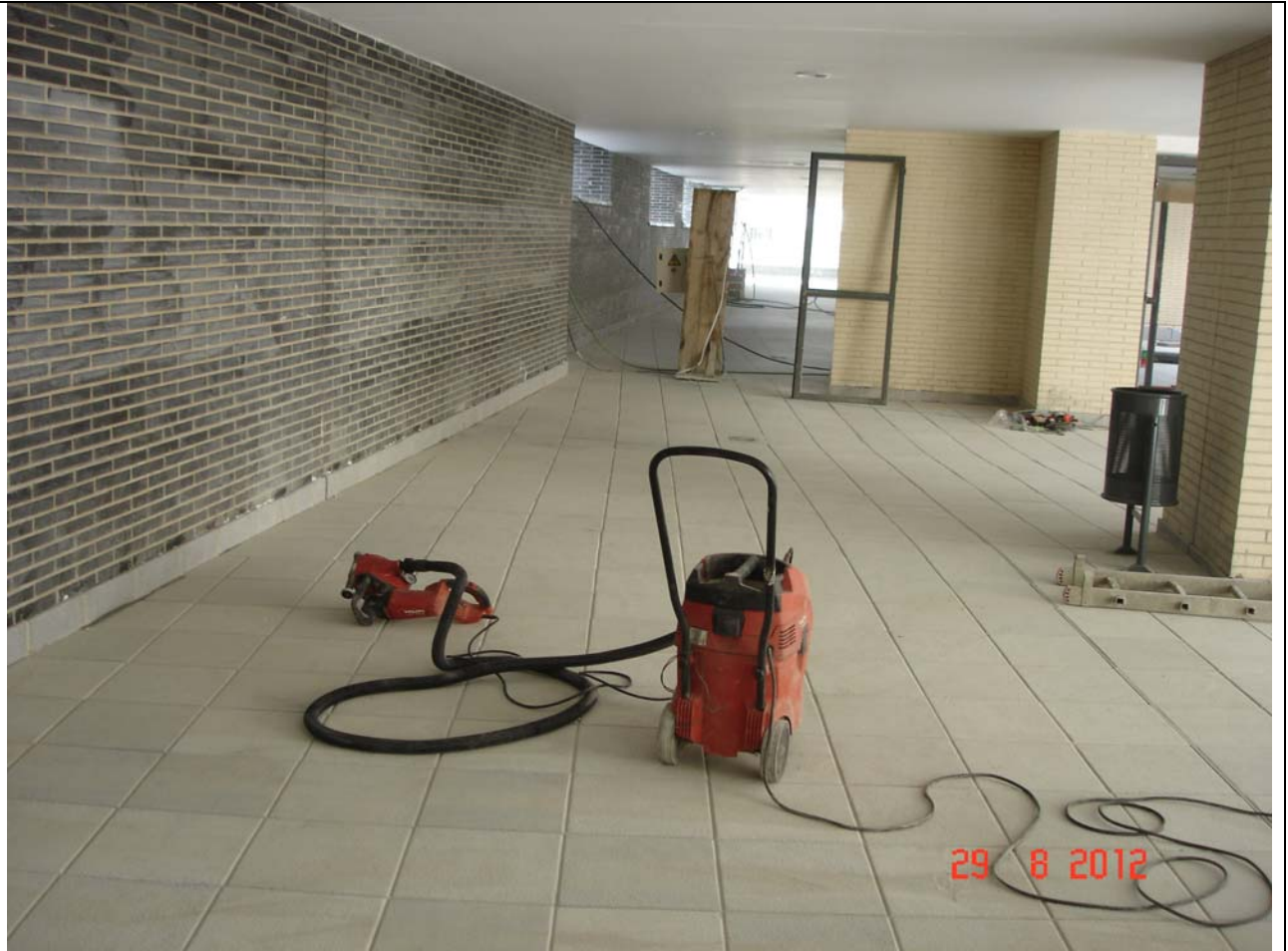
Solados de soportales.
