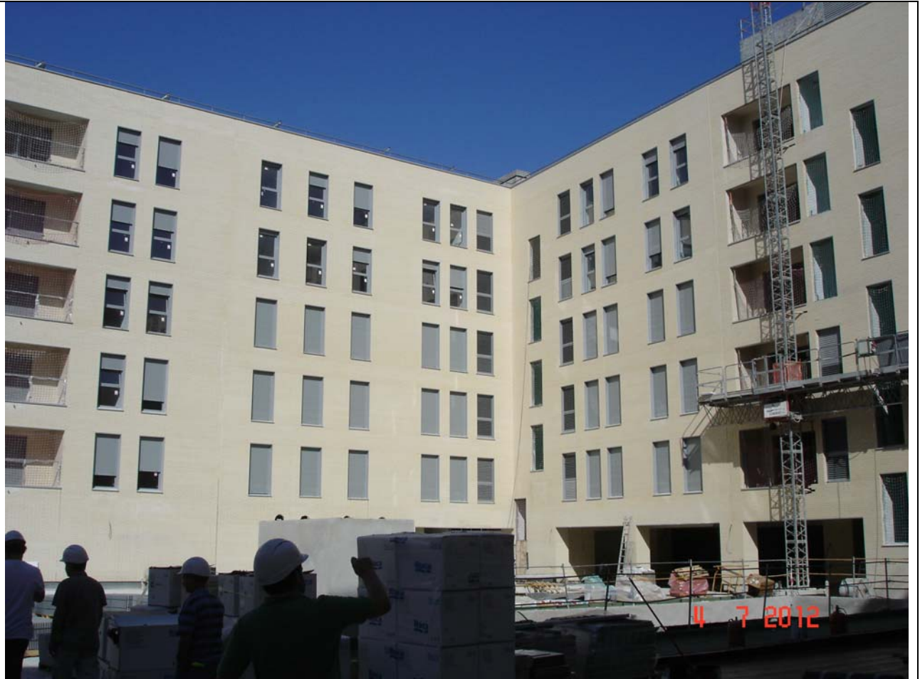
Fachada interior carpintería y acristalamientos.
