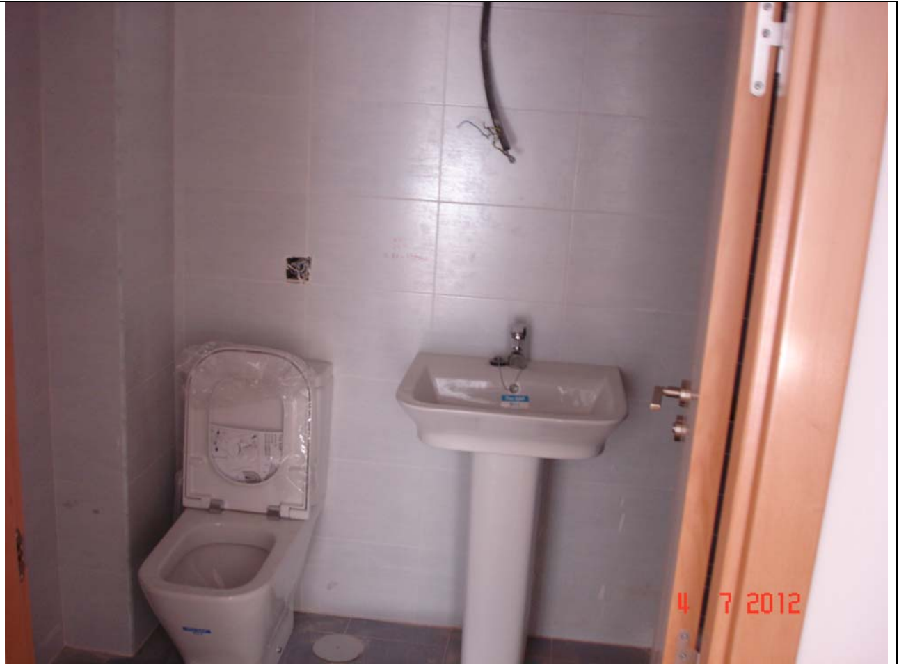
Aparatos sanitarios colocados.
