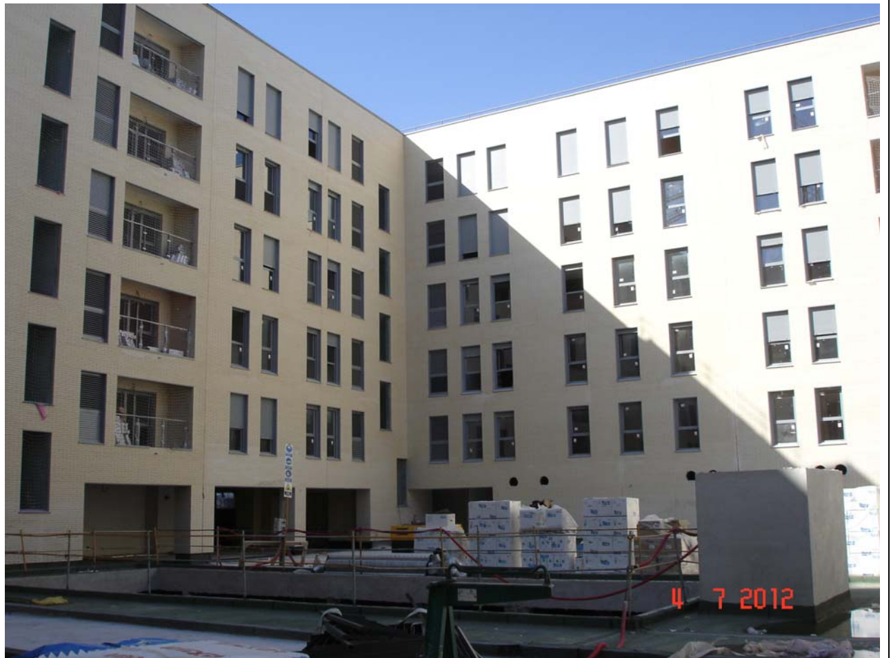
Patio interior estado general sin grua.
