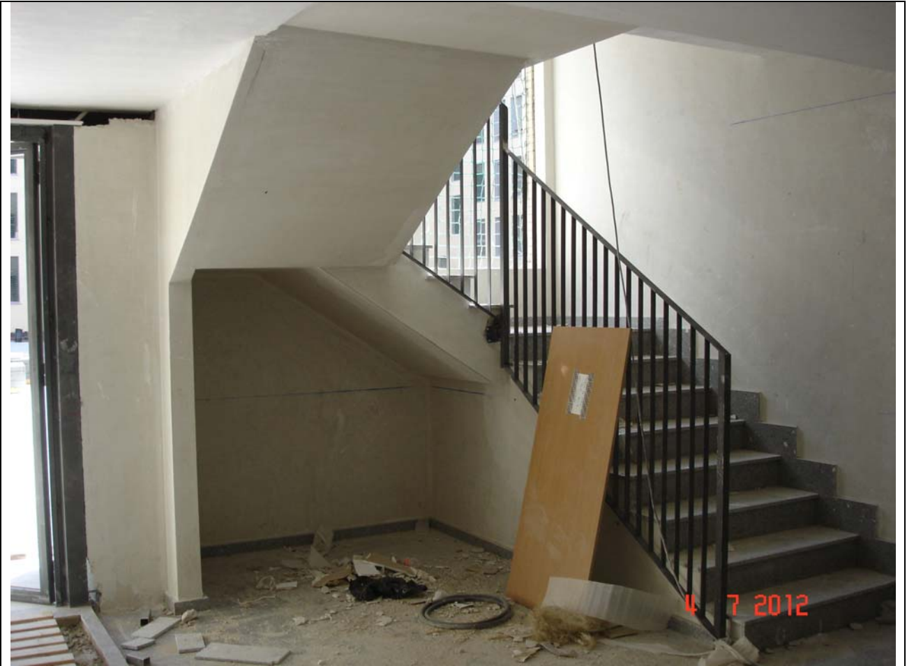
Arranque escalera en portal, barandilla .
