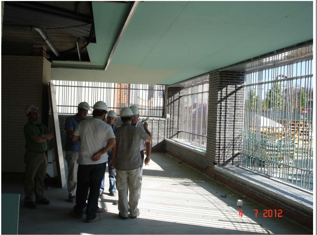
Vista soportales a fachada, rejas y falso techo.
