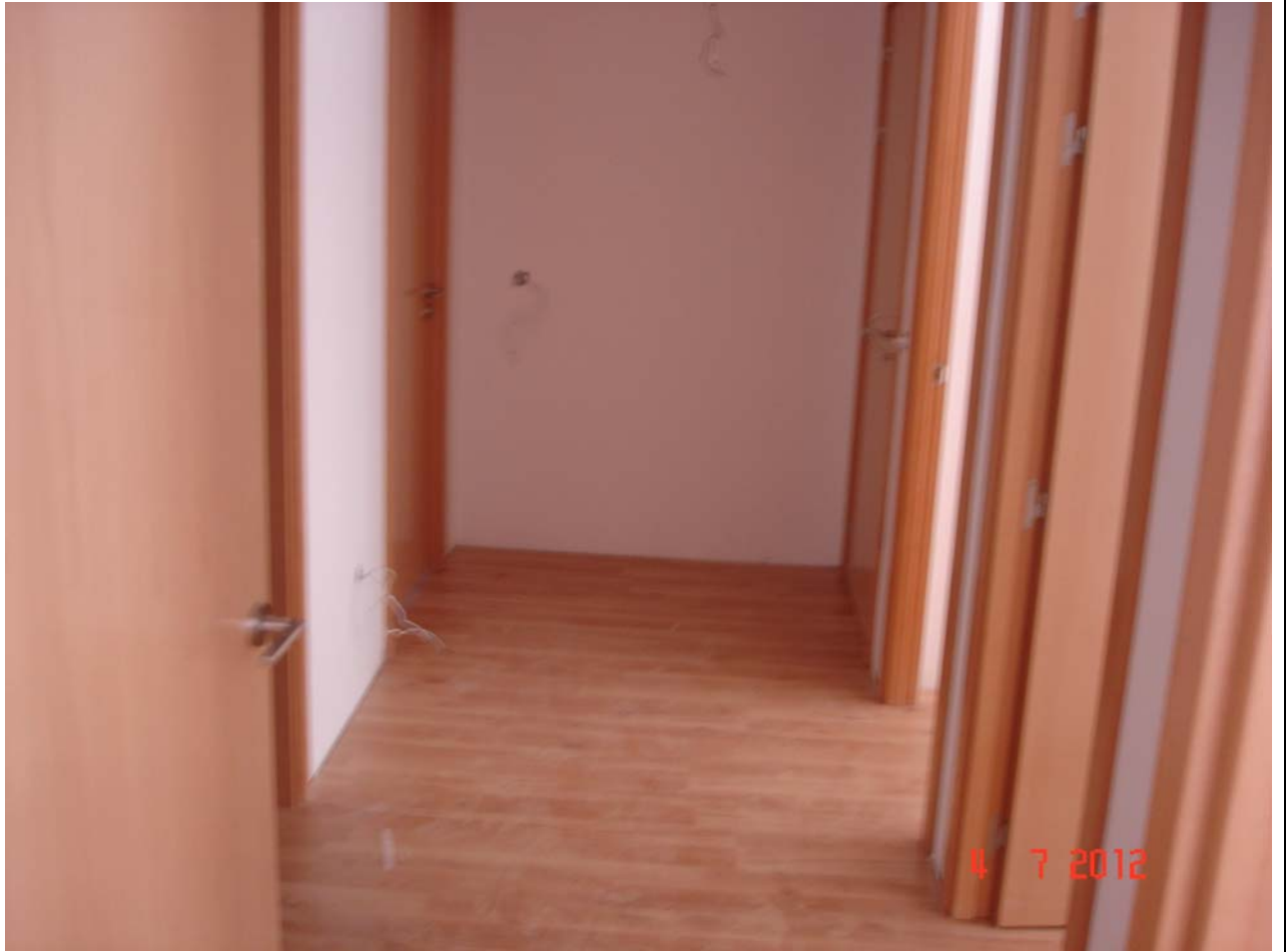
Vista interior vivienda con tarima y carpintería colocadas.
