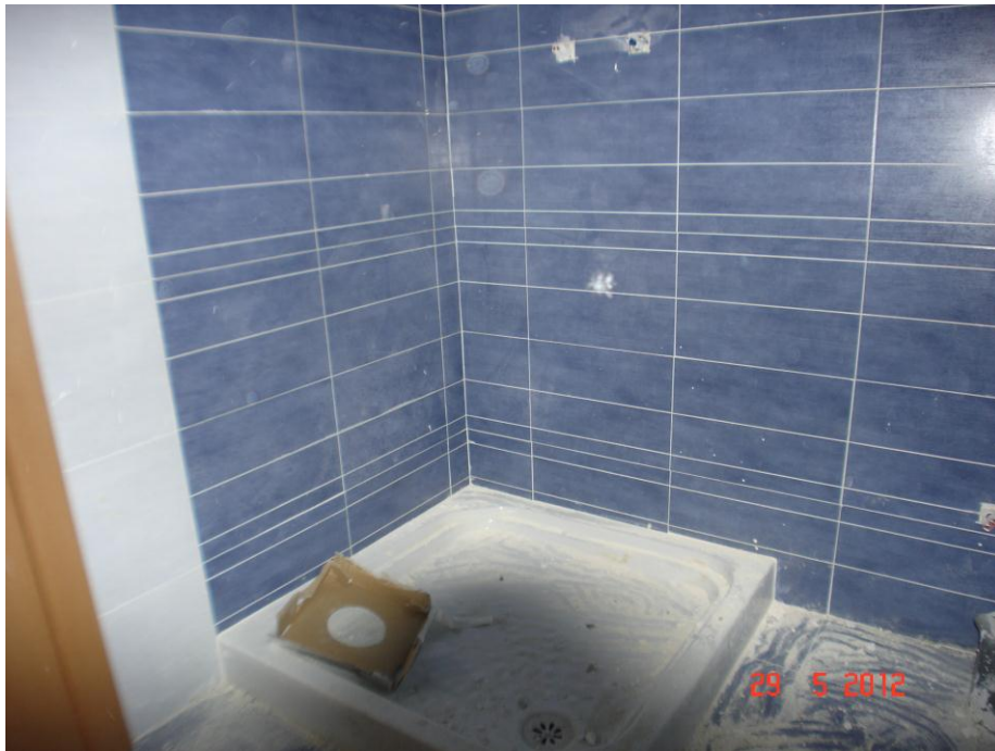
Alicatados baños y aseos.
