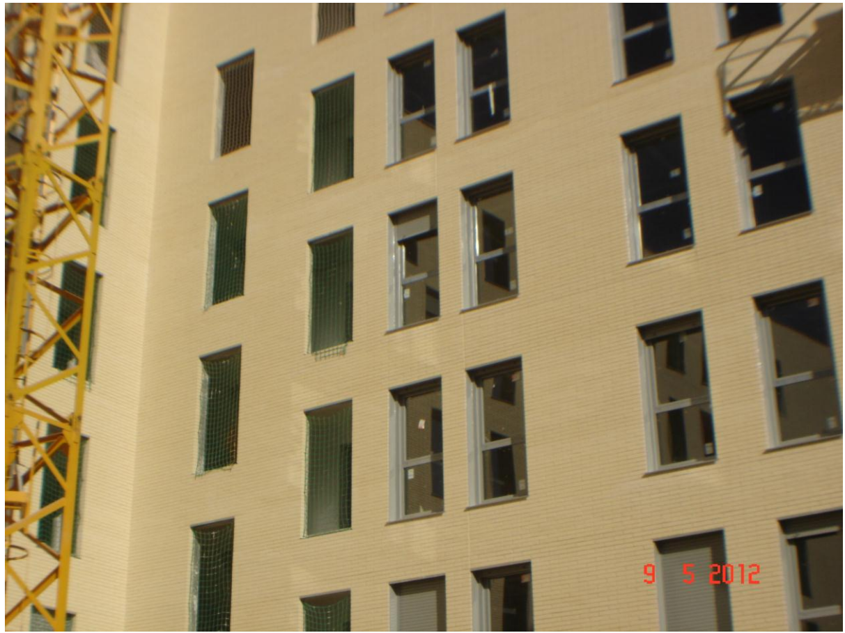
Vista patio interior con ventanas colocadas.
