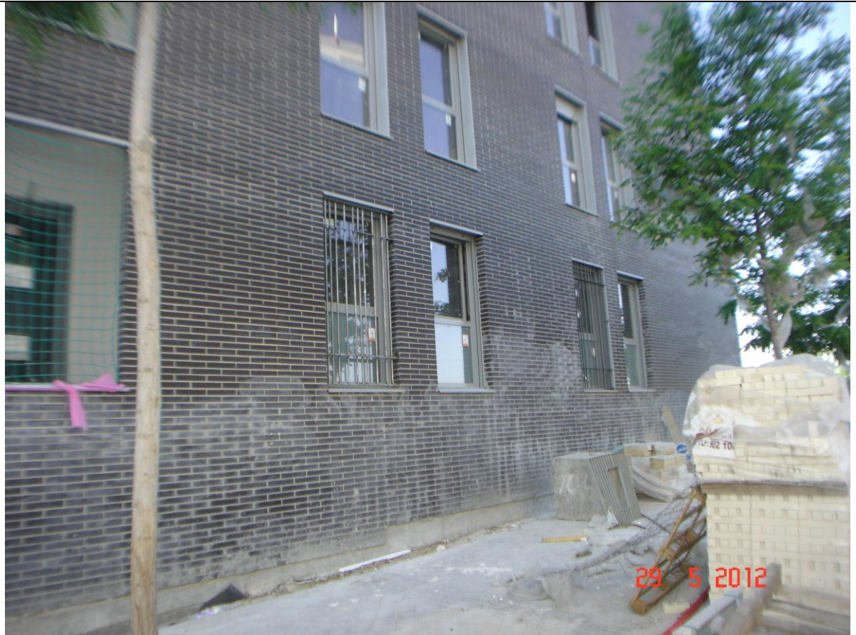
Fachada carpintería y acristalamientos y rejas.
