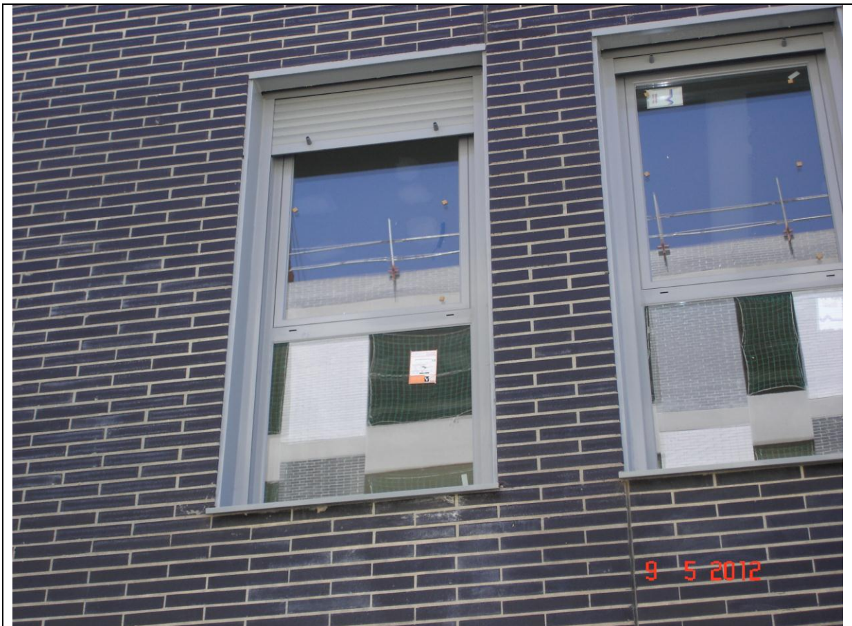
Detalle ventanas en fachada pral. Acristaladas y con persiana colocada.
