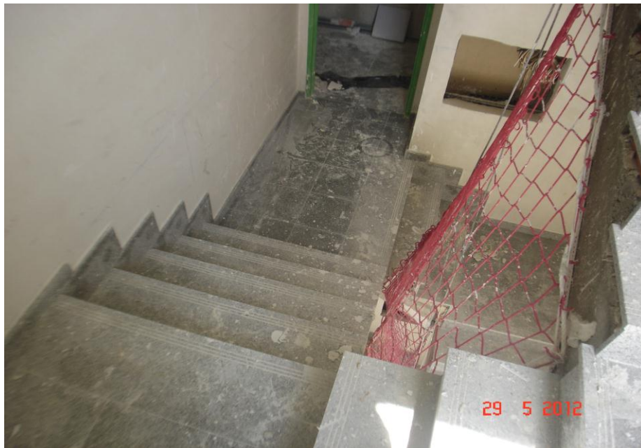
Vista peldaños escaleras y mesetas en granito.
