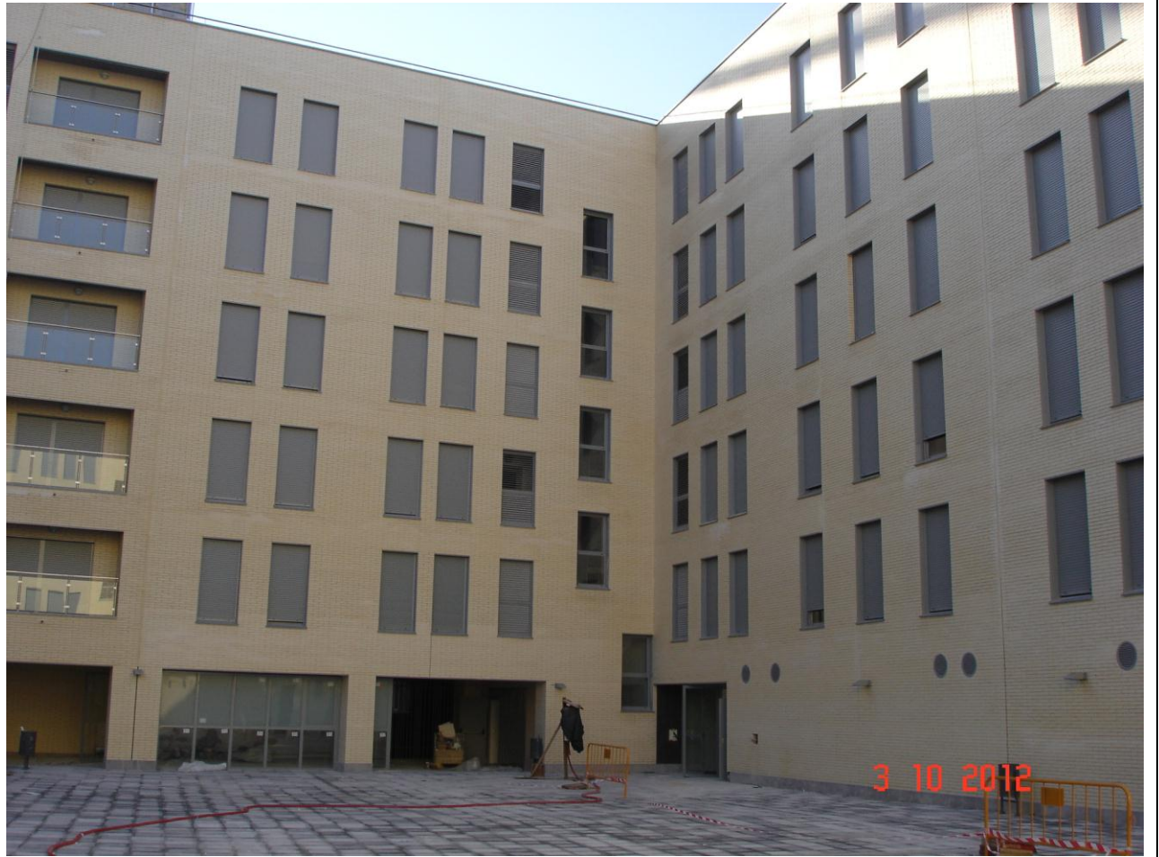
Patio interior estado general.
