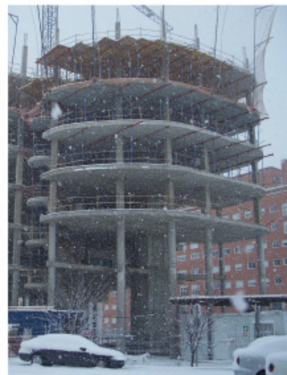
Estado de Obra a Fecha: 01/01/2010
