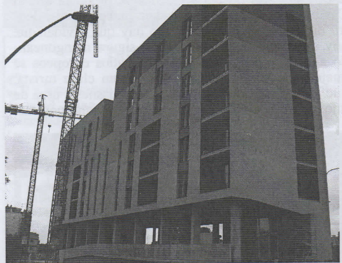
aspecto actual de los nuevos pisos
