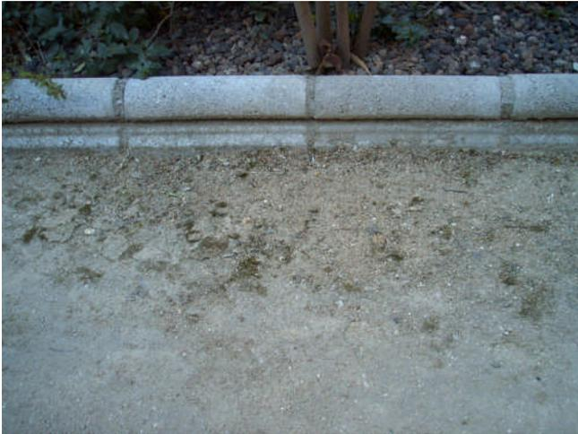
10.- En toda la zona existen bordillos con una media de 15 centímetros de altura sobre el terreno, lo que sumado a los otros 20 (aproximados) que tienen los cajeros, hacen un total de 35 centímetros disponibles para ganar cota sin afectar excesivamente al acabado estético. En cualquier caso, los recrecidos son puntuales en las zonas más alejadas de la arqueta actual, y en ningún caso en puntos altamente visibles.
