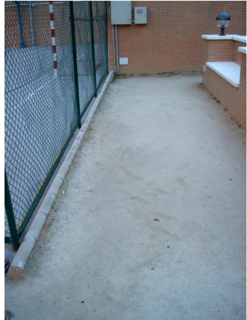
5.- **Un segundo tramo de drenaje será necesario** para resolver la alineación de las pistas de Paddle que más se encharcan. Dada la alineación de las farolas existentes, se recomienda hacerlo por el lateral derecho de la fotografía hasta engarzar con la rejilla de la zona anterior, por lo cual esta unión habrá de preverse en la "T" que se forme.
