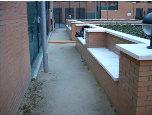
Se estima que con un desnivel de 21 centímetros entre la solera del cajero al fondo de la imagen y la cota de desagüe de la actual arqueta existente se daría circulación a las aguas de un modo satisfactorio, y también se cree que la sección del cajero actual es suficiente para ser copiada por las nuevas alineaciones y que desagüe adecuadamente.
