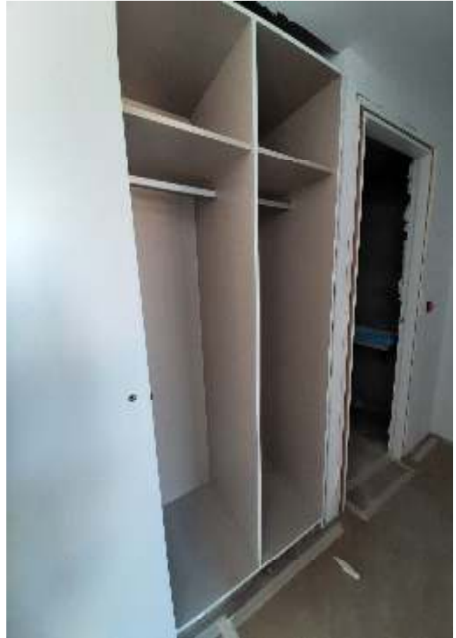
MONTAJE DE ARMARIO
