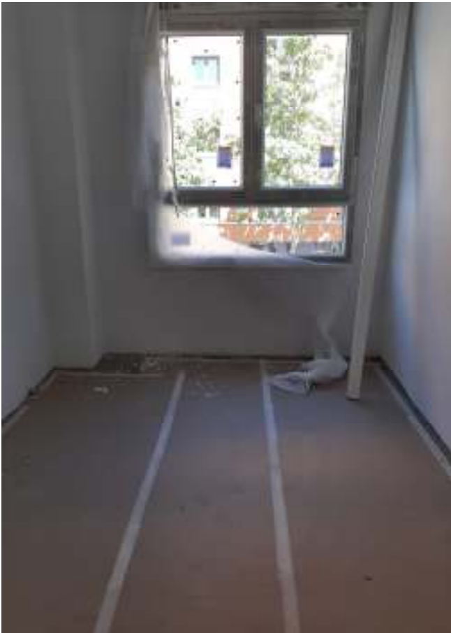
CARPINTERIA MONTADA EN DORMITORIO
