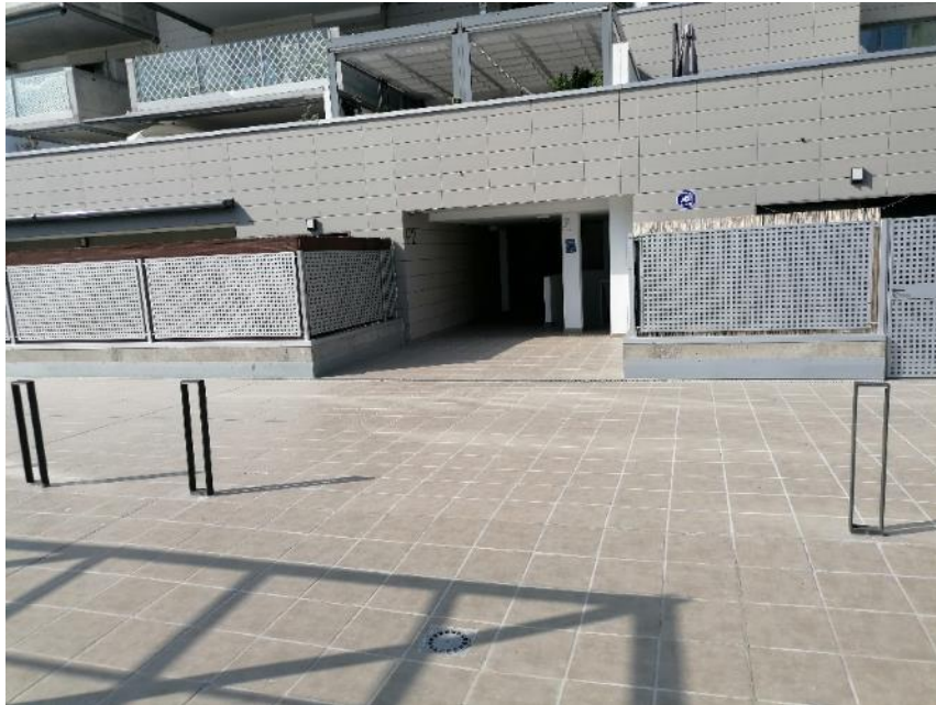
Zona exterior portales y tramos de pasillo circulación sin iluminación
