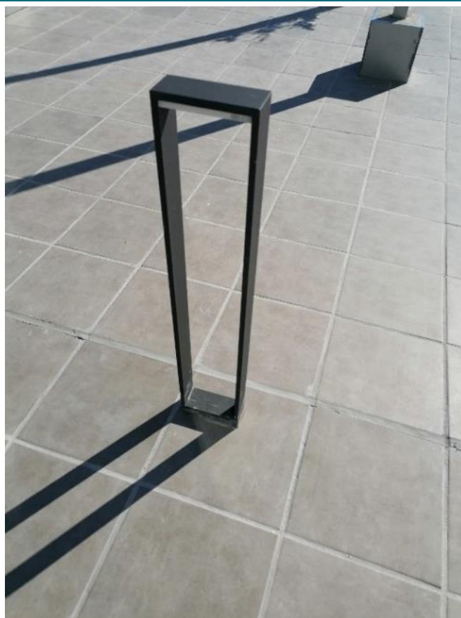
Balizas ALP mod. 74452 instaladas en pasillo central
