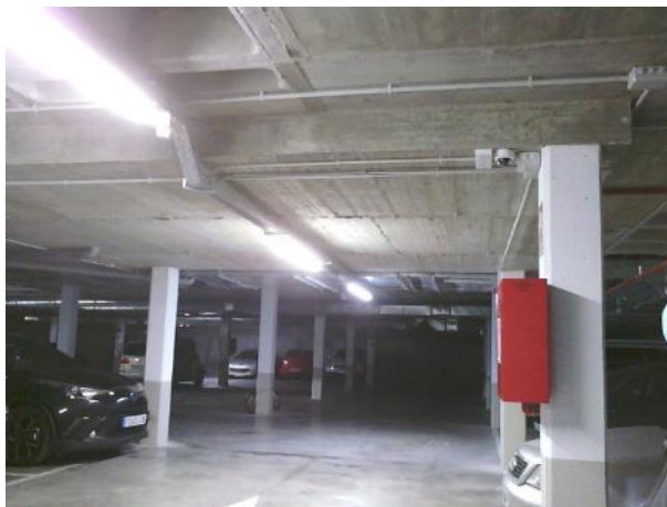
Forjado en el entorno del sumidero B
