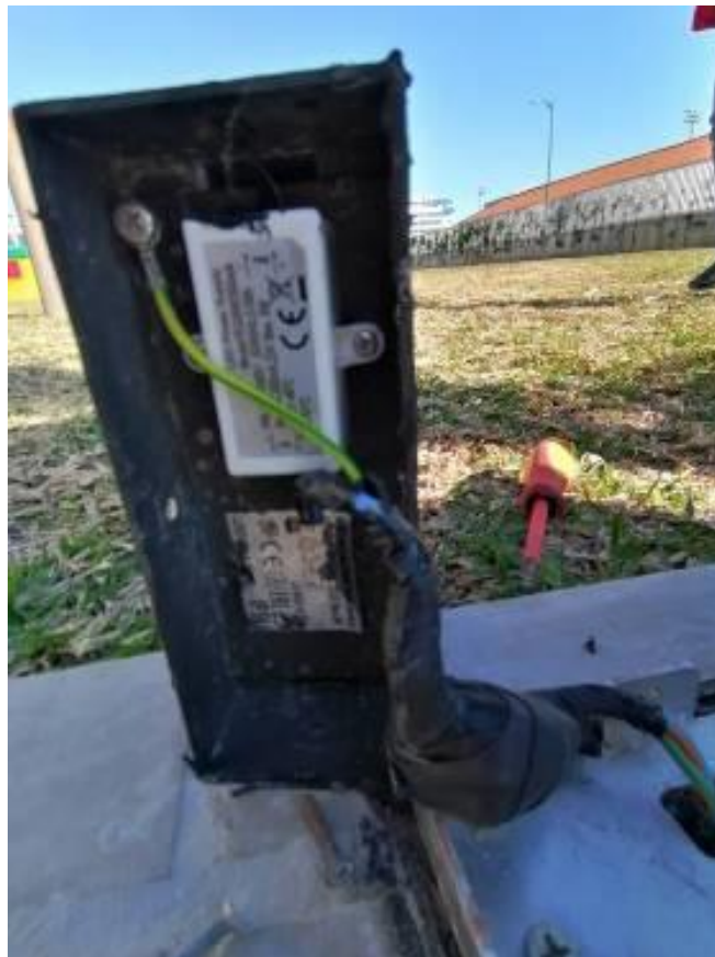
Conexión eléctrica de baliza reparada
