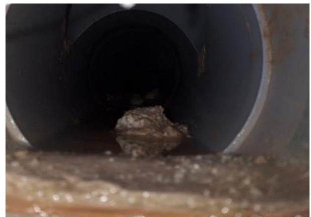
Falta de conexión en el sumidero 5
