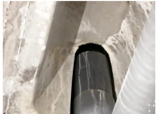
Falta de conexión en el sumidero 5
