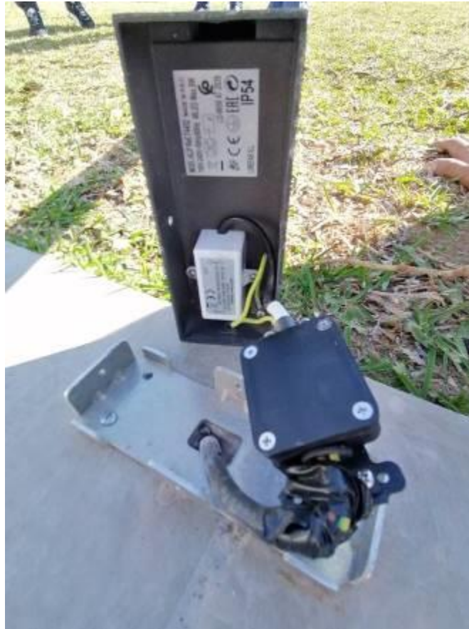
Conexión eléctrica de baliza de nueva instalación
