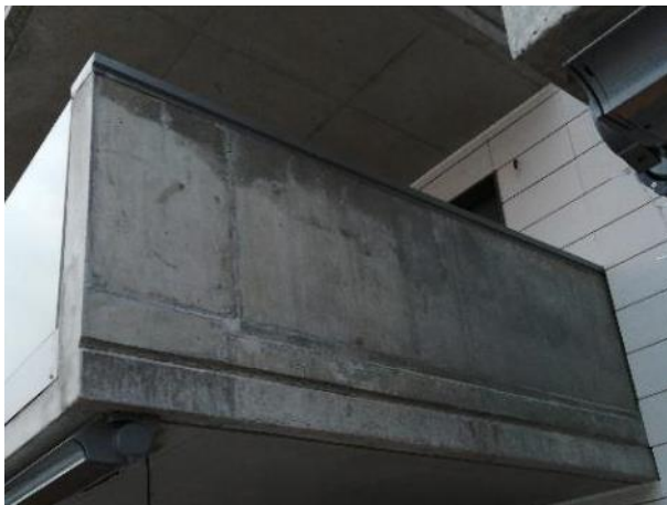
Hormigón visto ejecutado
