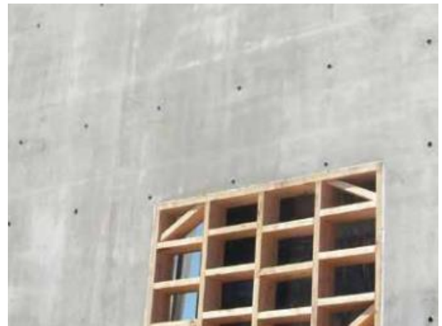
Ejemplo de hormigón visto Lafarge
