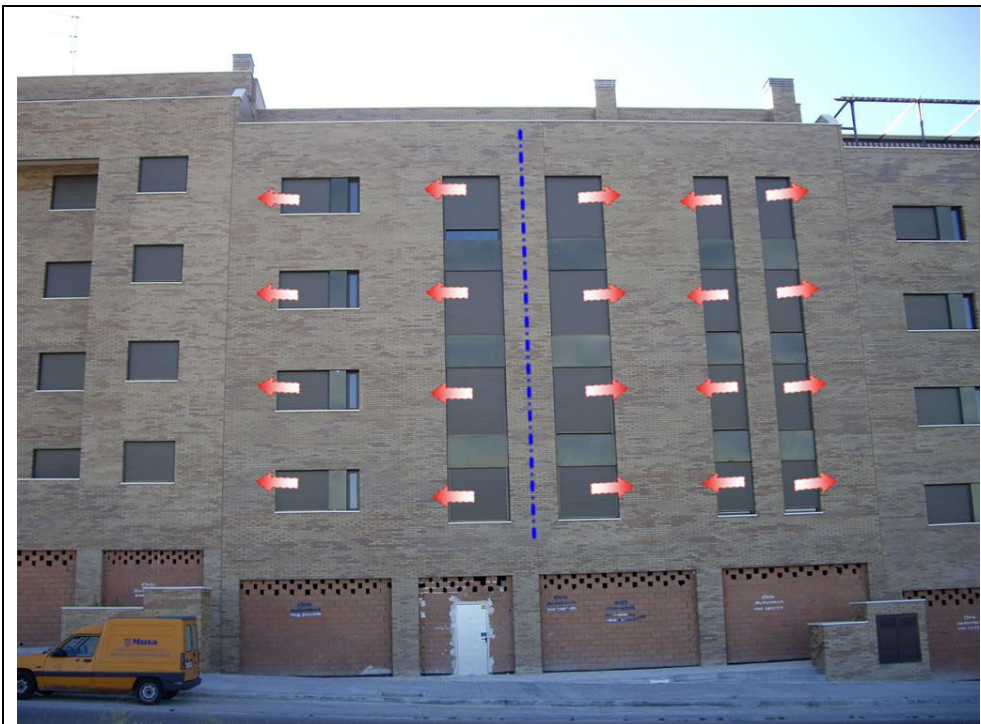
FACHADA OESTE AGUSTINA DE ARAGÓN 2-10
