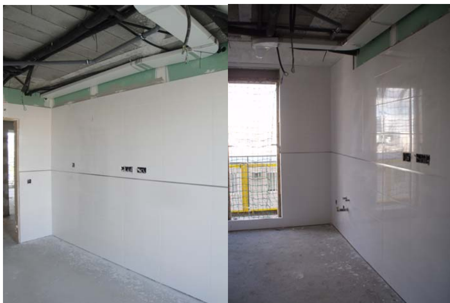
VISTA INTERIOR ALICATADO COCINA
