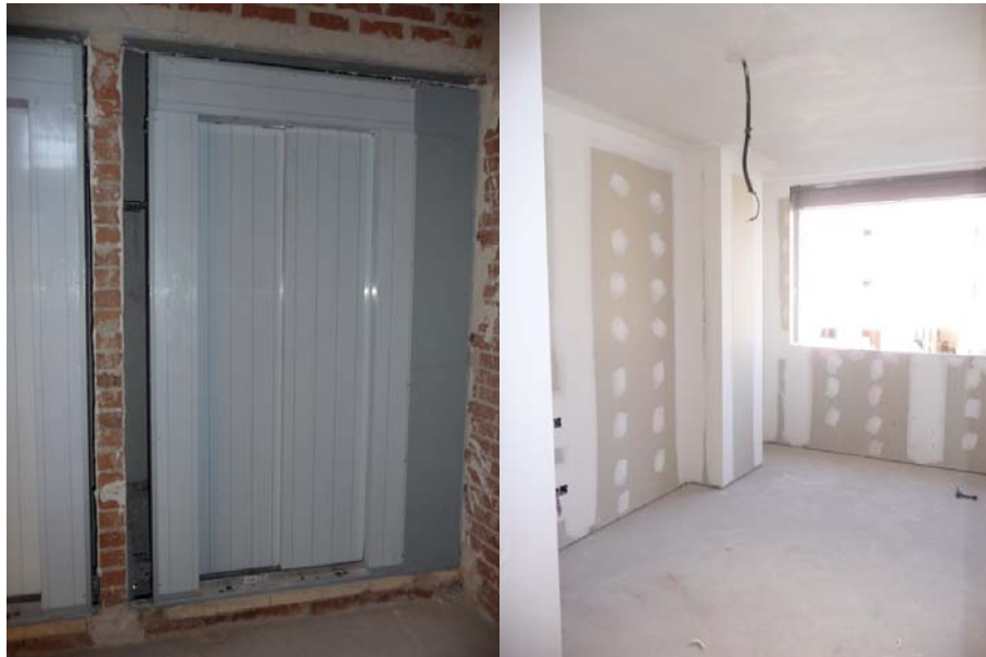
VISTA ASCENSOR PORTAL. VISTA INTERIOR VIVIENDA
