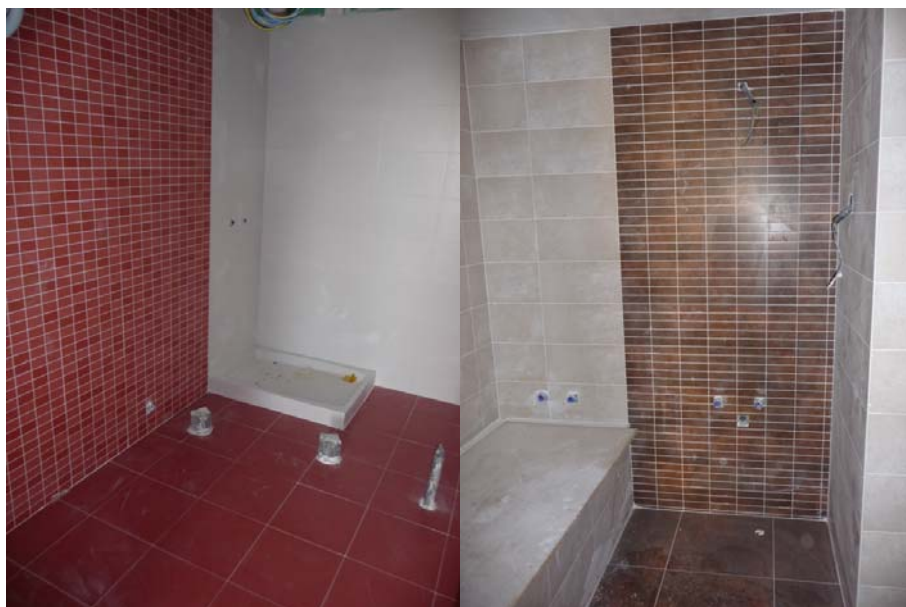
VISTA ASEO Y BAÑO
