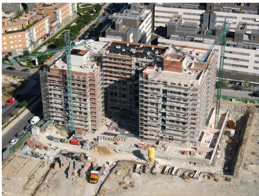
VISTA AEREA DEL EDIFICIO AGOSTO 12
