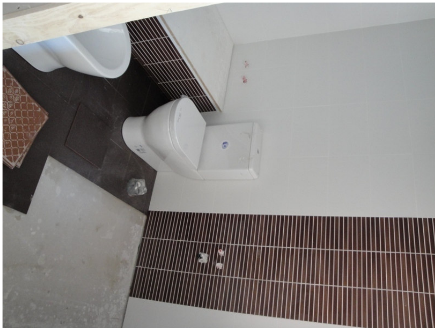
ALICATADO, SOLADO Y SANITARIOS DE BAÑO PRINCIPAL
