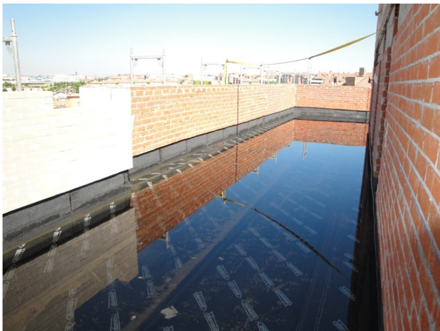
PRUEBAS DE ESTANQUIDAD TERRAZAS DE ATICOS
