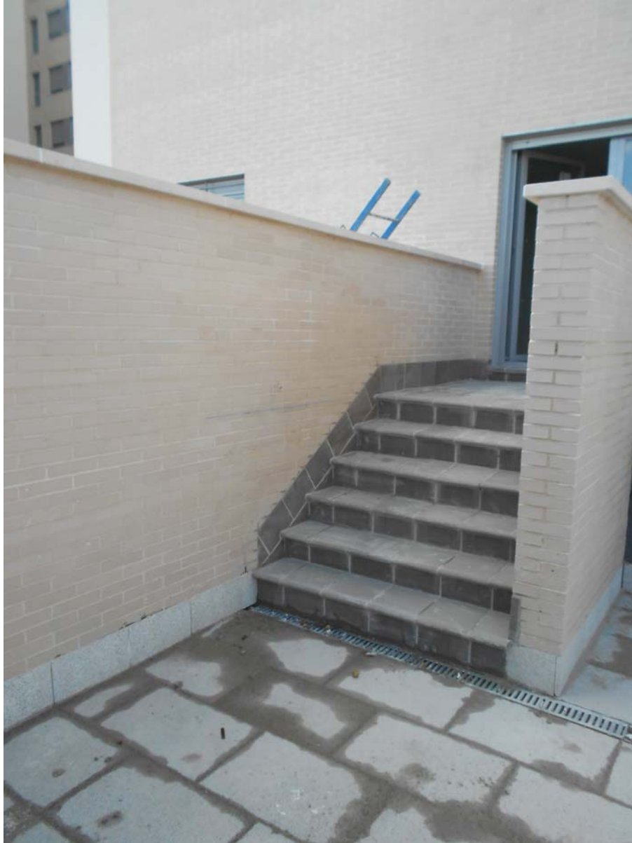
SOLADO DE TERRAZAS EXTERIORES
